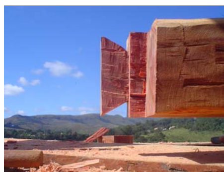
FIGURA 124 Pousada: foto do “rabo de andorinha”- em execução e pronto Fonte: Imagens cedidas pelo arquiteto, setembro 2008
