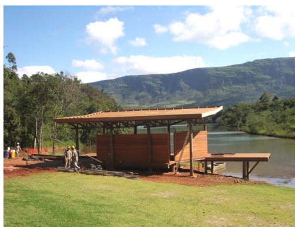
FIGURA 109 Parque 2- Pavilhão da Contemplação: em construção Fonte: Imagem cedida pelos arquitetos em outubro de 2008
