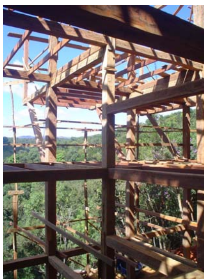
FIGURA 74 Pousada: montagem da estrutura Fonte: Imagem cedida pelo arquiteto
