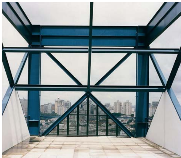
FIGURA 123 Edifício Comercial I: Foto do terraço- Detalhe da estrutura/guarda-corpo Fonte: Imagem cedida pelo arquiteto, agosto 2008
