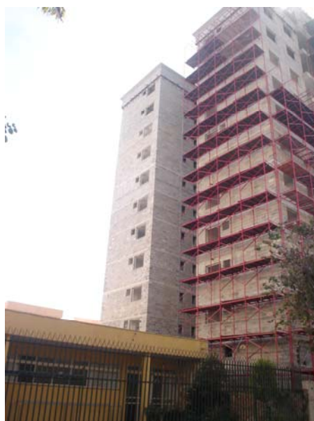
FIGURA 45 Edifício Residencial 1 em construção- agosto 2008 Fonte: Foto nossa
