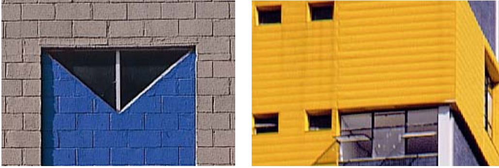
FIGURA 125 Detalhes diversos Fonte: Imagens cedidas pelos arquitetos
