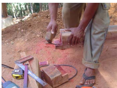
FIGURA 124 Pousada: foto do “rabo de andorinha”- em execução e pronto Fonte: Imagens cedidas pelo arquiteto, setembro 2008
