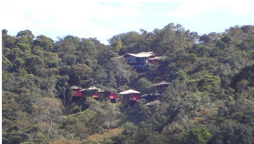
FIGURA 72 Pousada: relação edifícios-entorno Fonte: Imagens cedidas pelo arquiteto em setembro 2008
