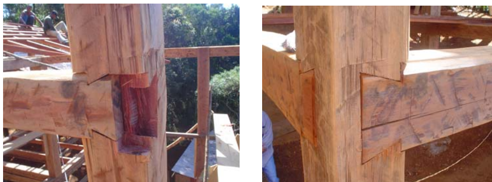
FIGURA 66 Pousada: detalhe dos encaixes dos pilares/vigas Fonte: Imagens cedidas pelo arquiteto em setembro 2008
