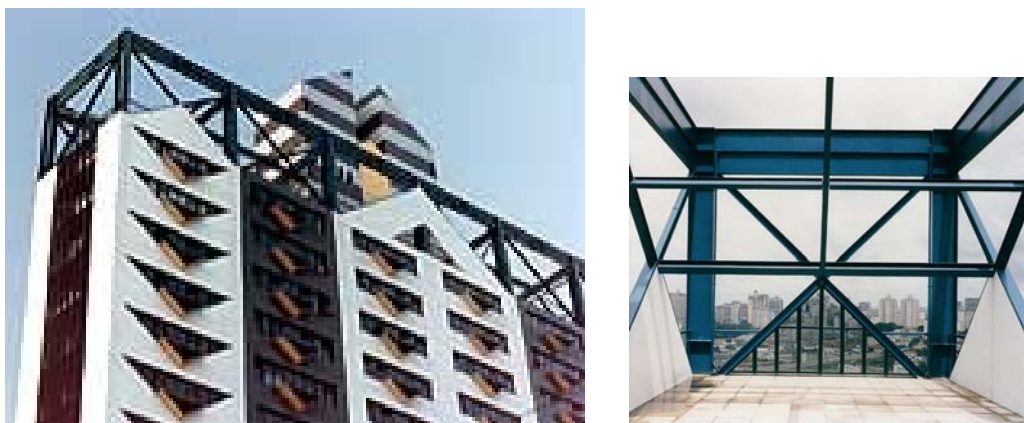
FIGURA 20 Edifício Comercial 1: estrutura, janelas e terraços Fonte: Imagens cedidas pelo arquiteto em agosto de 2008
