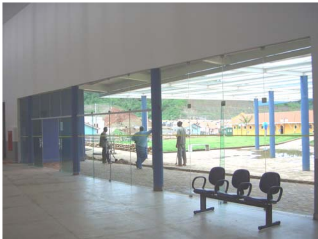
FIGURA 105 Prefeitura: Vista do interior para a área exterior sob o pergolado Fonte: Imagem cedida pelos arquitetos em outubro de 2008
