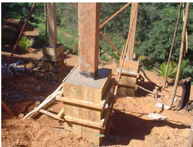
FIGURA 75 Pousada: fundação e pilares Fonte: Imagem cedida pelo arquiteto em setembro 2008
