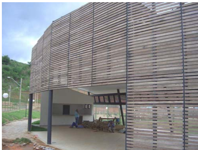
FIGURA 32 Parque: salão (edifício pronto) Fonte: Imagem cedida pelos arquitetos em outubro de 2008
