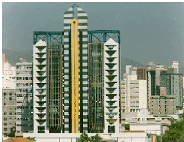
FIGURA 23 Edifício Comercial 1: edifício pronto Fonte: Imagem cedida pelo arquiteto
