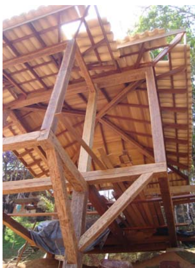
FIGURA 113 Pousada: Estrutura de madeira Fonte: Imagem cedida pelo arquiteto
