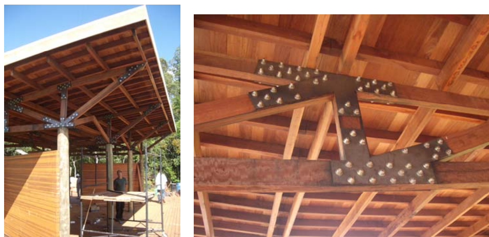
FIGURA 92 Parque 2- Pavilhão da Contemplação: Detalhe das peças metálicas nas tesouras dos telhados Fonte: Imagens cedidas pelos arquitetos
