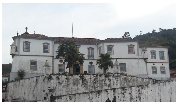
FIGURA 151 - Sobrado 10 (Escola de Minas) que apresenta menos aberturas em relação ao contexto da praça e base em superfície opaca.
