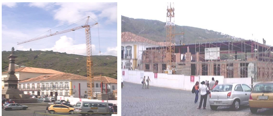
FIGURAS 126 e 127 – A grua próxima ao monumento em homenagem a Tiradentes. A estrutura metálica recuada já pronta, e a alvenaria sendo construída para escondê-la no alinhamento.
