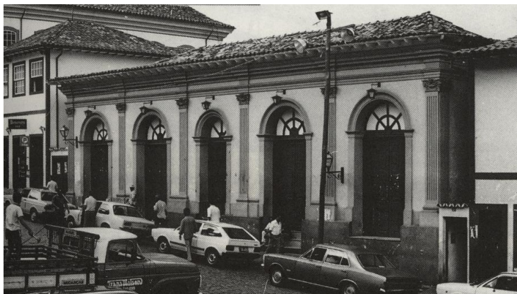
FIGURA 73 - Fachada Cine Vila Rica na década de 80, após a reforma. Observa-se também, que durante este período, no terreno localizado entre o sobrado e o Liceu, foi construído uma edificação “colonial”.
