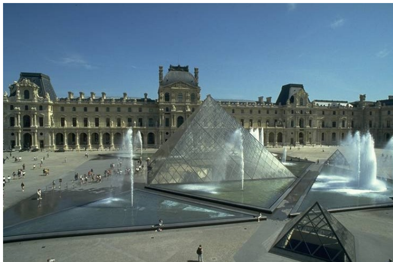
FIGURA 30 – Pirâmide do Louvre, em Paris, França. Detalhe dos espelhos d'água e das pirâmides menores.
