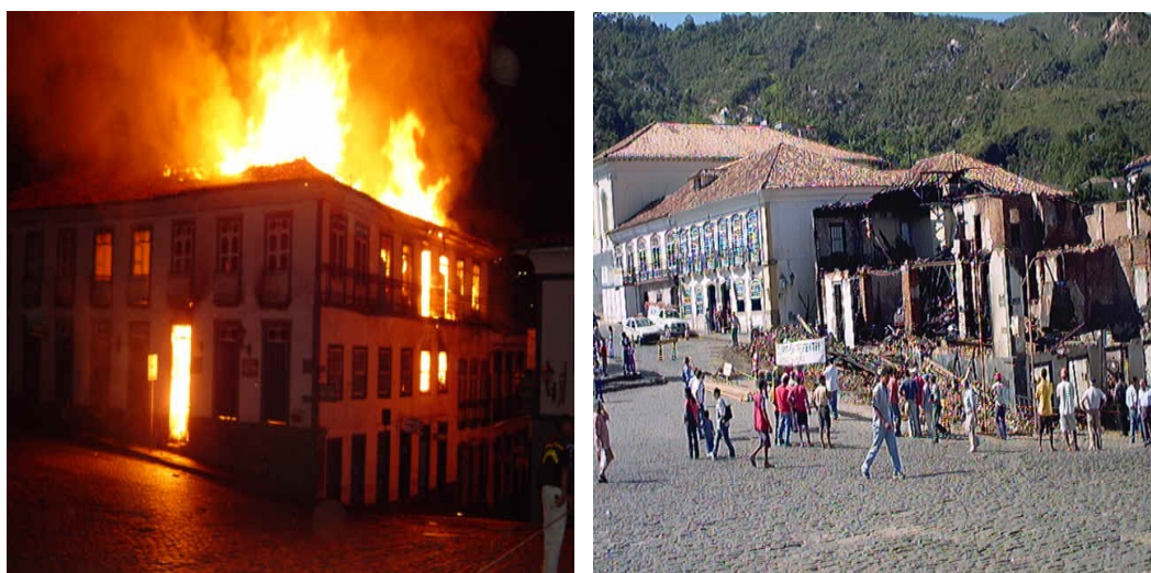
FIGURAS 90 e 91 - Edifício do Hotel Pilão, incendiado em 14 de abril de 2003.
