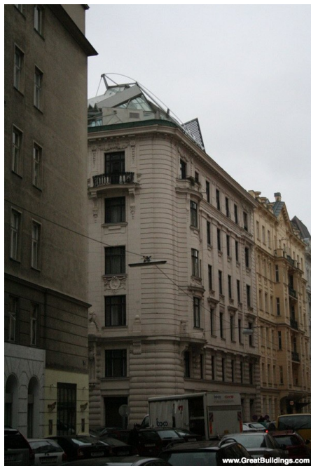
FIGURA 31 – O Office Extension, em Vienna, Áustria. Observa-se que o volume respeita a escala do entorno.
