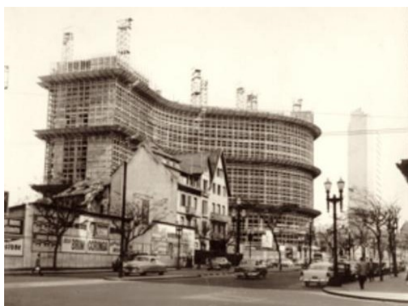
FIGURA 45 - O Edifício Copan em construção, tendo a frente a Vila Normandia, demolida durante a década de 1960, para a construção de novos edifícios.
