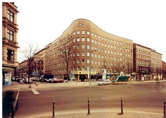
FIGURA 25 – Edifício Bonjour Tristesse, em Berlim. Intervenção de pequeno impacto com o meio circundante.
