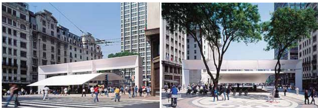
FIGURAS 55 e 56 - Pórtico e cobertura metálicos vistos a partir do viaduto do Chá, a obra emoldura edificações de várias épocas da história de São Paulo, desde o século XVII até os anos 70. O piso em forma de arabesco, degradado por várias obras, foi reconstituído.
