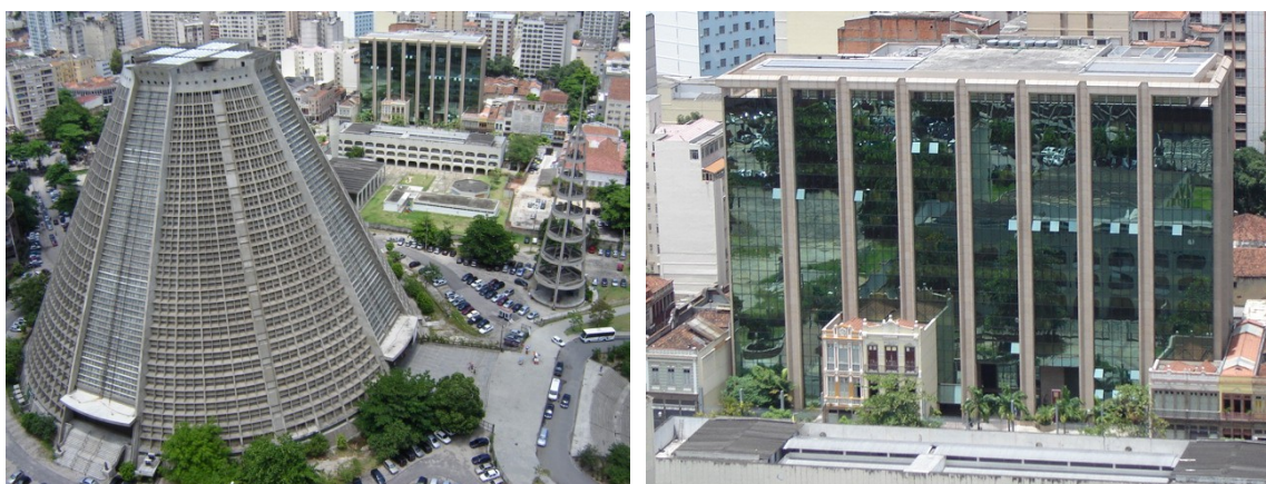
FIGURAS 52 e 53 - Em primeiro plano a Catedral Metropolitana de São Sebastião, com seu volume cônico anterior ao Projeto do Corredor Cultural. Ao fundo o CIEP de Oscar Niemeyer e o edifício do novo Fórum, com volumetria e inserção distintas das sugestões contidas no manual. Detalhe do edifício do novo Fórum, e um “falso” modelo de preservação, onde é desconsiderada a morfologia em prol da preservação apenas da fachada.
