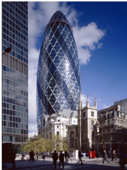
FIGURA 34 – Torre da Swiss Re HQ, em Londres, Inglaterra. É um edifício de quarenta andares e duzentos metros de altura, que se destaca de longe pela forma insólita, contrastante com o cenário circundante, mas justificada por uma série de vantagens distributivas, construtivas e de implantação. A estrutura acaba contraventada por suas conexões diagonais.
