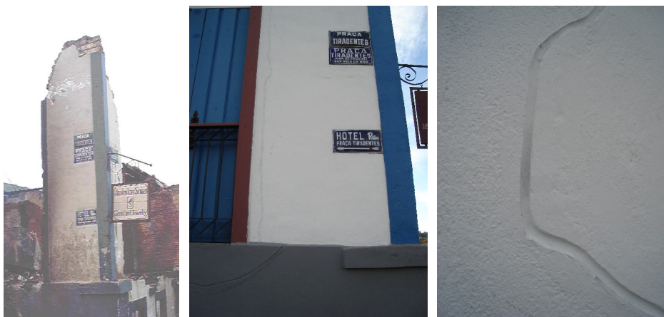
FIGURAS 128, 129 e 130 – Fotos dos fragmentos preservados da fachada da edificação e detalhe de como foram adicionadas à nova construção.
