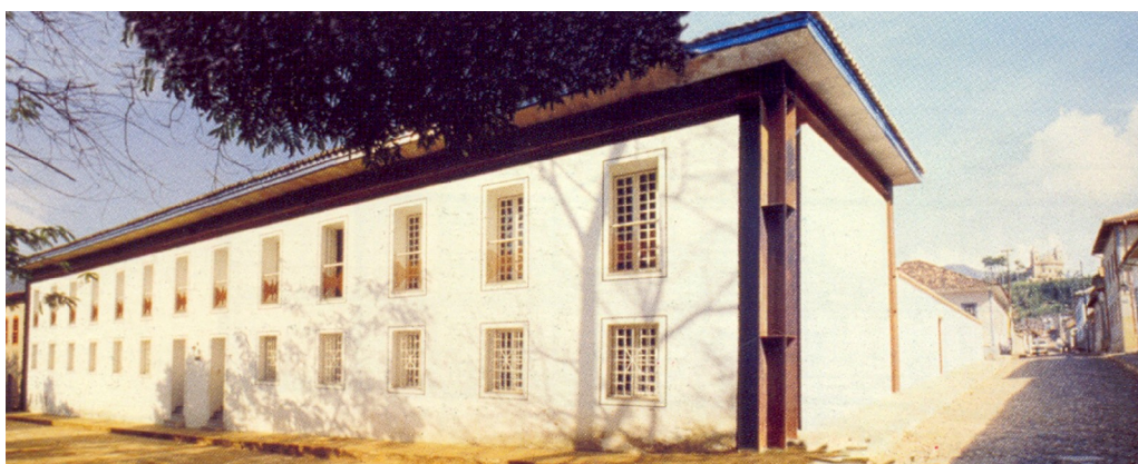
FIGURA 102 - Foto da casa, com o detalhe do enquadramento em estrutura metálica.
