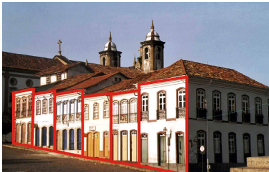
FIGURA 149 - Conjunto de sobrados (01, 02, 03, 04, 05 e 06) com proporção de predominância vertical.
