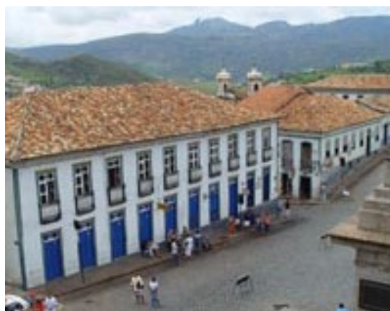
FIGURA 123 – A edificação onde funcionava o Hotel Pilão antes do incêndio.
