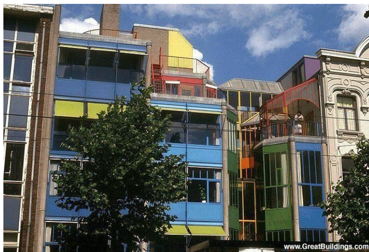
FIGURA 09 – Hubertus House, em Amsterdam, Holanda. Apesar de apresentar movimentação na fachada, manteve o gabarito das edificações vizinhas. Destacando o contraste dos materiais de revestimento da fachada em cores primárias.
