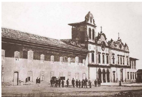
FIGURA 47 – Vista do largo de São Francisco, Convento de São Francisco e São Domingos as igrejas de São Francisco de Assis da Venerável Ordem dos Frades Menores e das Chagas do Seráfico Pai São Francisco da Venerável Ordem Terceira de São Francisco da Penitência, ainda com suas feições originais de taipa de pilão. O conjunto é um dos bons exemplos da arquitetura religiosa praticada em São Paulo no período colonial.
