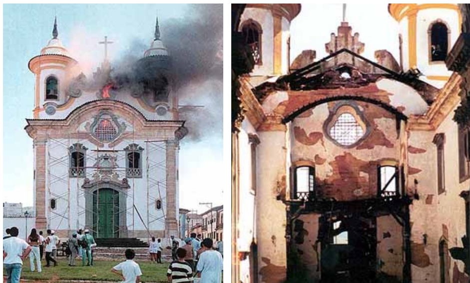
FIGURAS 87 e 88 - Igreja do Carmo, Mariana, sendo incendiada no dia 20 de janeiro de 1999 Seu interior após o incêndio.
