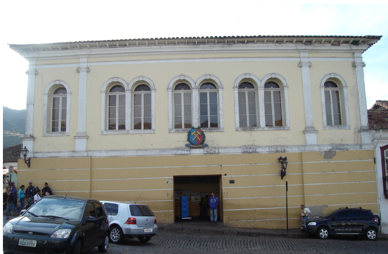
FIGURA 154 - Edificação 11 (CAEM), em estilo eclético com alvenaria pintada na cor ocre.
