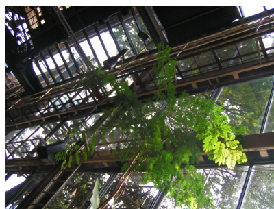
FIGURA 174 – Detalhe da iluminação zenital do Teatro Oficina. Fonte: Foto do autor, 2009
