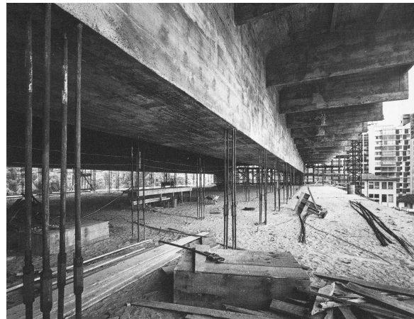
FIGURA 39 – Vista da viga principal com os tirantes de sustentação do primeiro andar.
