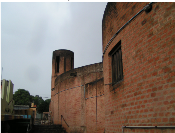
FIGURA 89 – Vista dos fundos da igreja.
