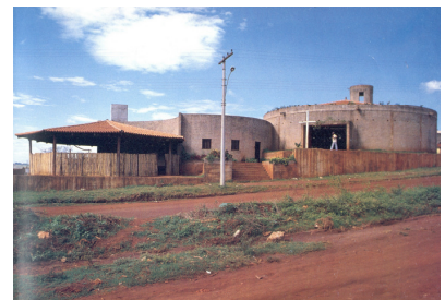
FIGURA 69 – Vista geral da época da construção.
