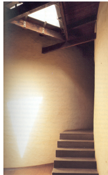
FIGURA 86 – Vista da iluminação zenital na circulação da residência das freiras.
