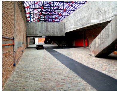
FIGURA 129 – Vista do foyer do auditório. Fonte: Foto do autor, 2009
