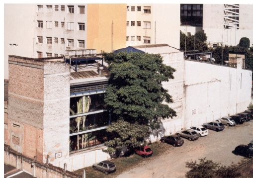
FIGURA 152 – Vista de uma das fachadas laterais do Teatro Oficina. Fonte: OLIVEIRA, 2002, p. 185
