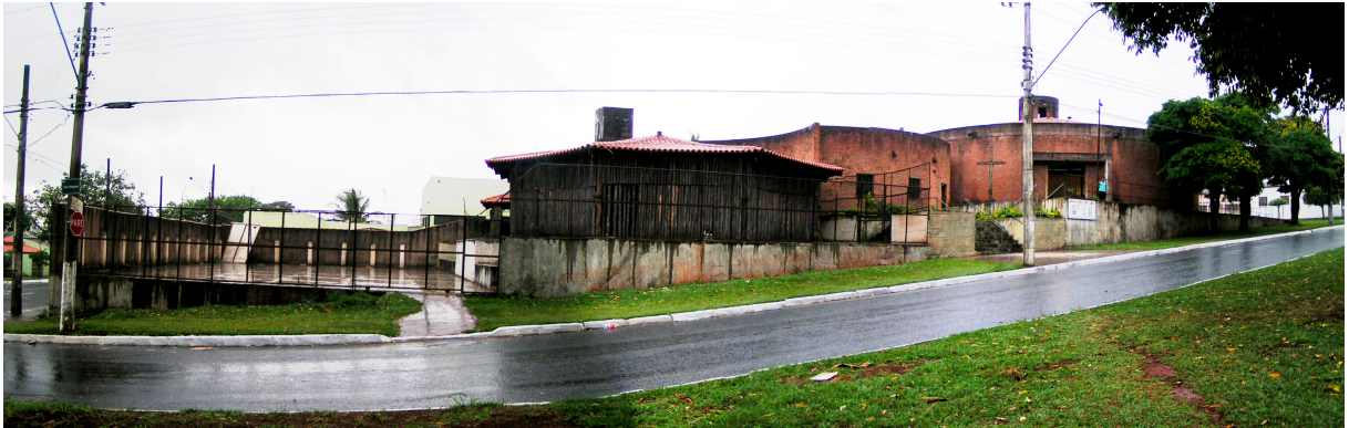
FIGURA 66 – Vista geral do conjunto da igreja, a partir da Avenida dos Mognos.
