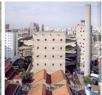
FIGURA 111 – Vista geral do SESC Pompéia. Fonte: OLIVEIRA, 2006, p. 200
