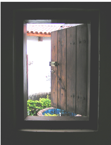
FIGURA 78 – Vista da janela de um dos quartos da residência das freiras para o pátio interno.
