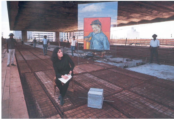
FIGURA 41 – Lina na obra do MASP, testando o cavalete. Fonte: FERRAZ, 2008, p. 105
