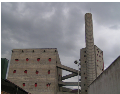
FIGURA 109 – Vista dos blocos esportivos. Fonte: Foto do autor, 2009
