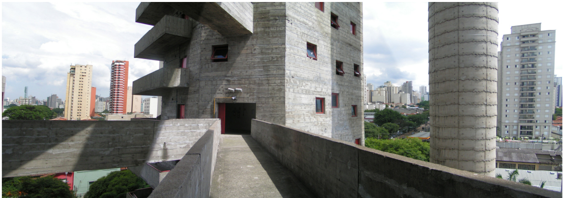
FIGURA 134 – Vista da passarela entre os blocos desportivos. Fonte: Foto do autor, 2009
