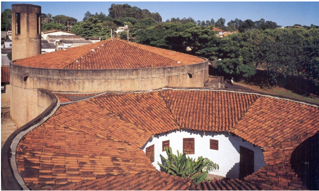
FIGURA 76 – Vista superior da Igreja, com o pátio interno em primeiro plano.
