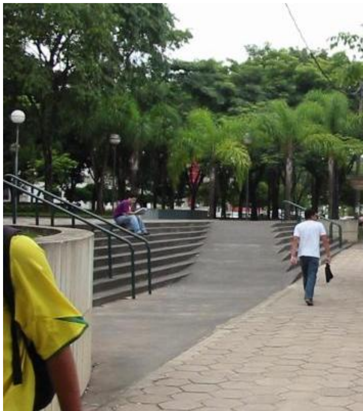
FIGURA 53 - Acesso à ECI - Escada entrecortada por rampas Fonte: GUIMARÃES, GRENFELL e PICCELI, 2007-09
