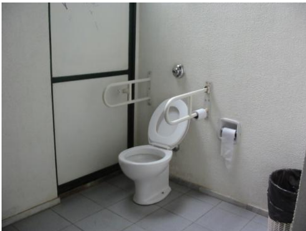
FIGURA 81 - Sanitário individual masculino acessível na ECI – bacia sanitária Fonte: GUIMARÃES, GRENFELL e PICCELI, 2007-09.
