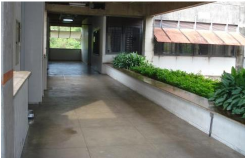
FIGURA 66 - FALE - Corredor de circulação do 3º. Pavimento
