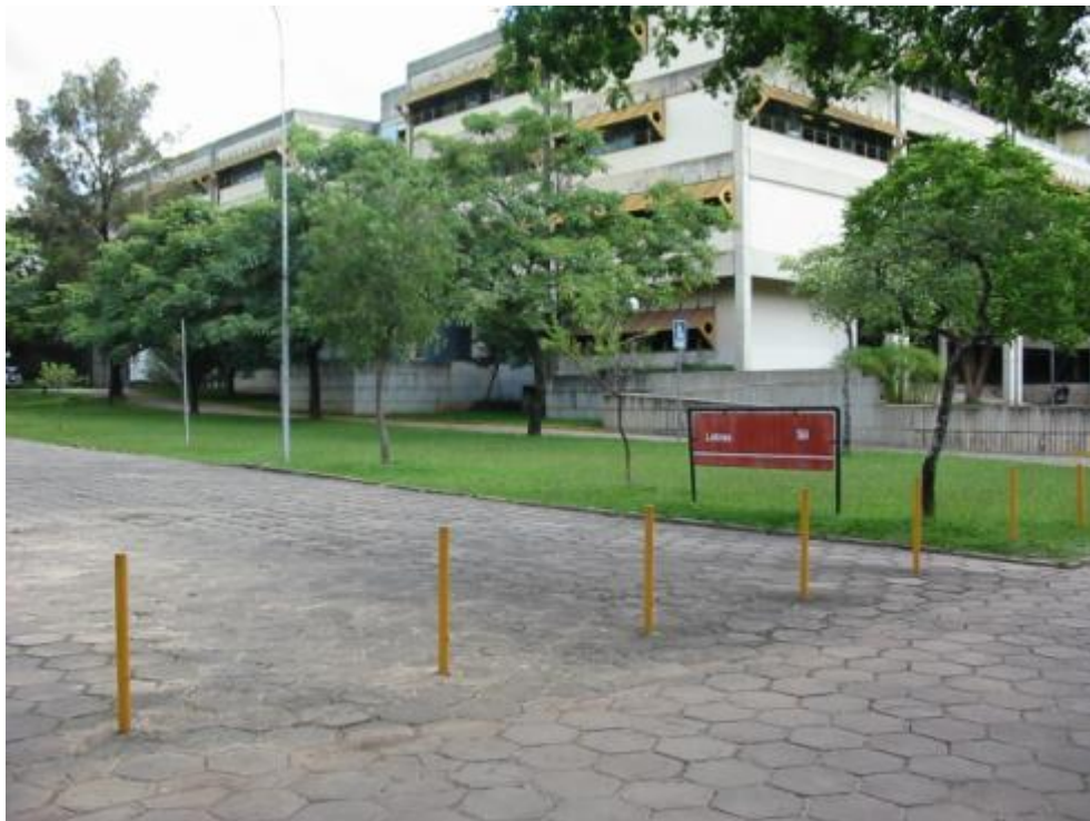
FIGURA 55 - Piso do acesso a FALE
