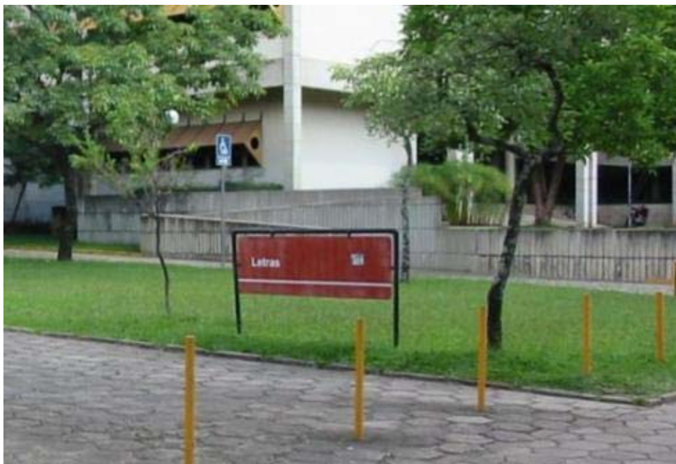
FIGURA 43 - Guias de balizamento nos canteiros ajardinados na entrada da FALE Fonte: GUIMARÃES, GRENFELL e PICCELI, 2007-09.
