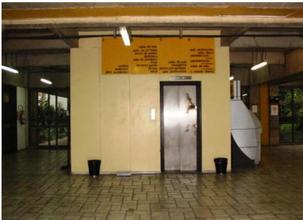
FIGURA 72 - Elevador da FALE
