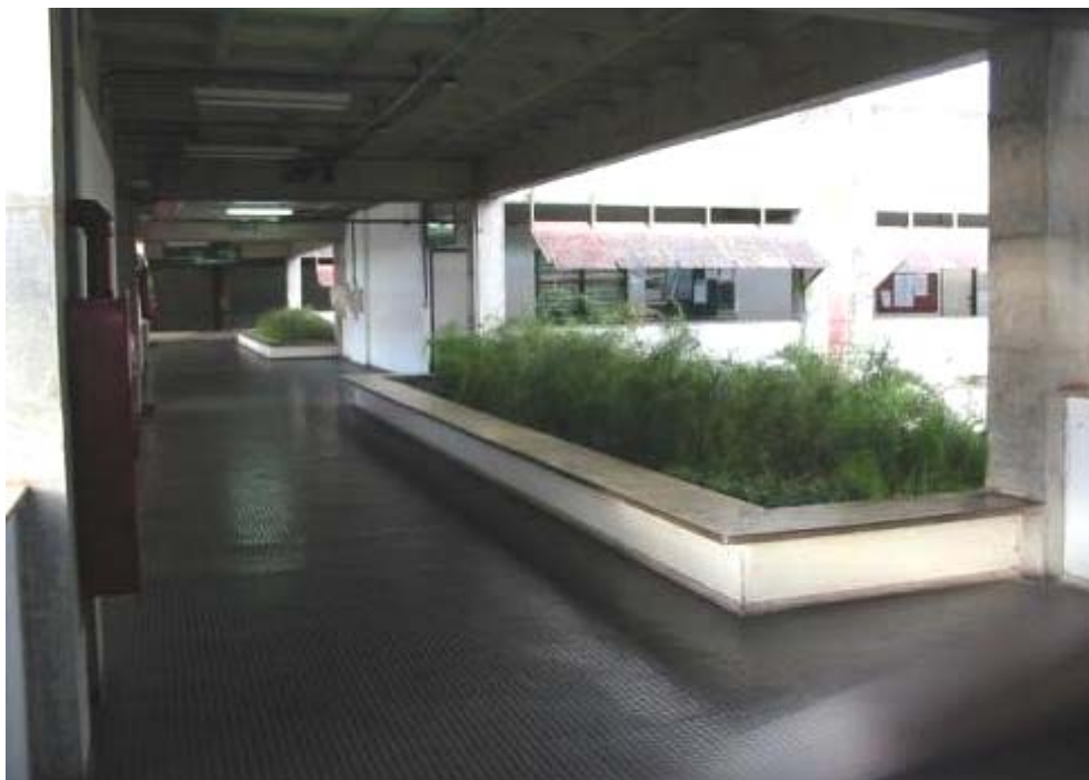
FIGURA 63 - Corredor interno no 4º. Pavimento da FAFICH
