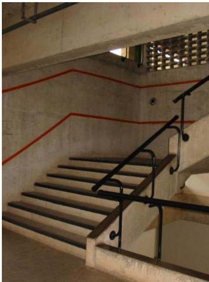
FIGURA 68 - Escada da FALE – corrimão e guardacorpo Fonte: GUIMARÃES, GRENFELL e PICCELI, 2007-09
