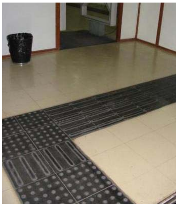
FIGURA 44 - Piso tátil da biblioteca da FAFICH Fonte: GUIMARÃES, GRENFELL e PICCELI, 2007-09.
