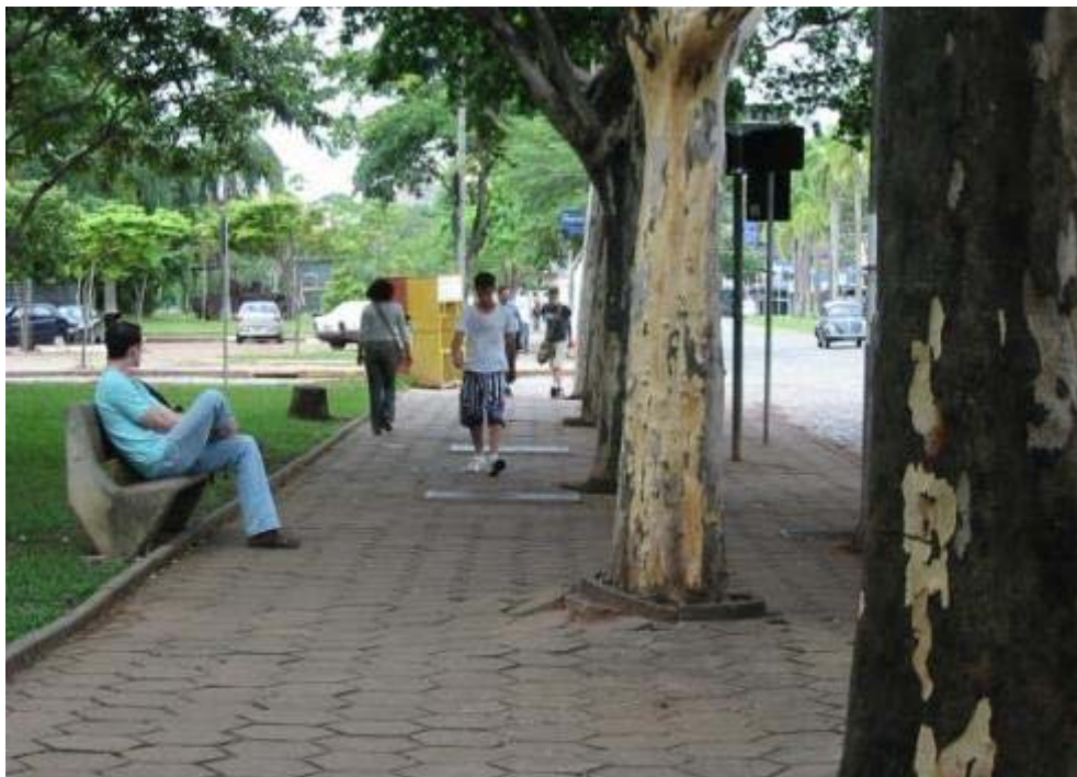
FIGURA 61 – Estado de conservação das calçadas Fonte: GUIMARÃES, GRENFELL e PICCELI, 2007-09.
