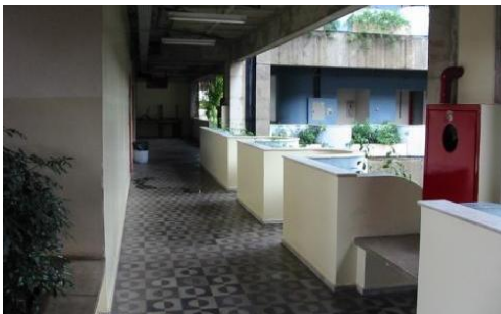
FIGURA 7 - Corredor de circulação dos pavimentos superiores – ECI
