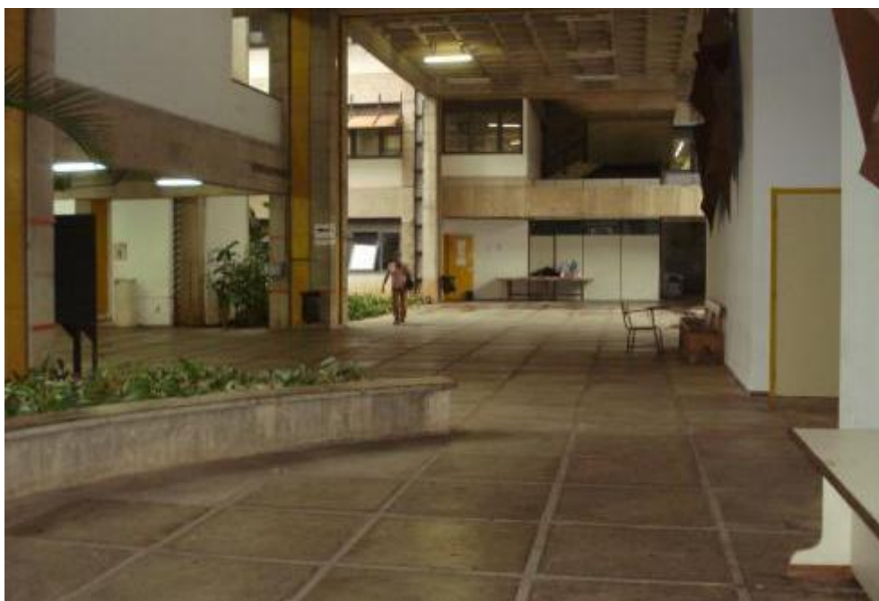
FIGURA 65 - FALE – circulação que leva ao auditório principal Fonte: GUIMARÃES, GRENFELL e PICCELI, 2007-09.
