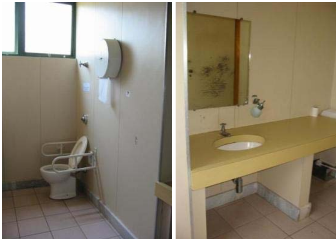
FIGURA 85 - Sanitário individual acessível unissex na FAFICH
