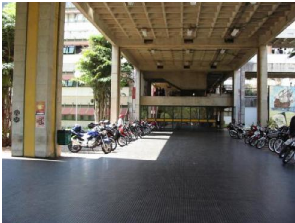
FIGURA 26 - Marquise de entrada da FAFICH – estacionamento de motocicletas Fonte: GUIMARÃES, GRENFELL e PICCELI, 2007-09
