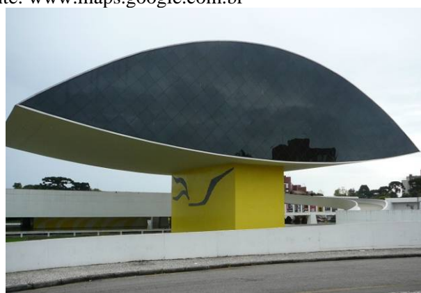
Figura 73 – Vista externa da entrada do MON. Fonte: Arquivo pessoal
