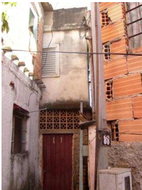
FIGURA 15 – Segundo pavimento de edificação obstruindo a janela da edificação vizinha – Vila Santa Rosa
