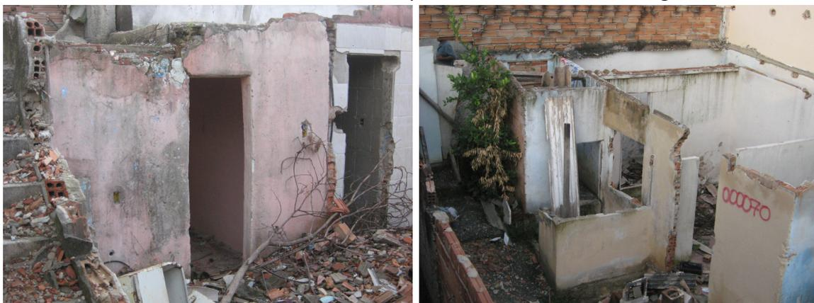
Figuras 32 e 33: Algumas casas da Vila Antena foram demolidas apenas parcialmente. Na segunda imagem é possível ver a marcação numérica em vermelho, que define as casas a serem demolidas. Fonte: Grupo MOM
