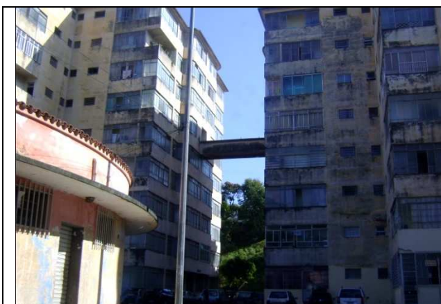
Figura 13 – Passarela que interliga blocos
