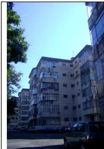
Figura 03 – Vandalismo e descaracterização das janelas da fachada
