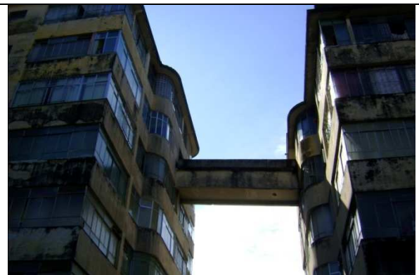
Figura 12 – Passarela que interliga blocos
