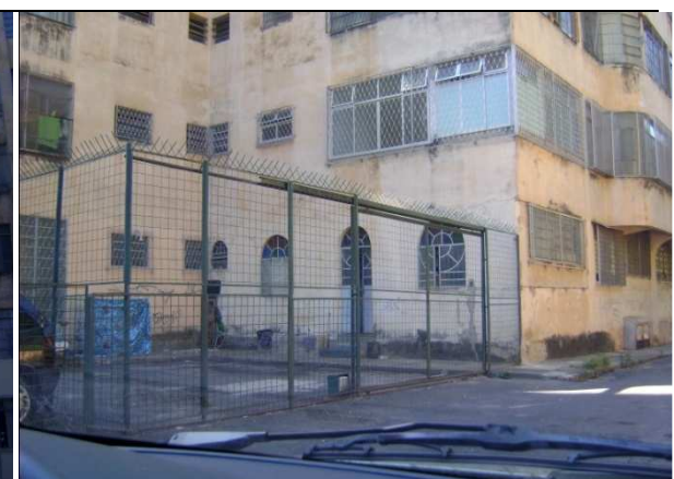
Figura 14 – Fachada descaracterizada e garagem com grade
