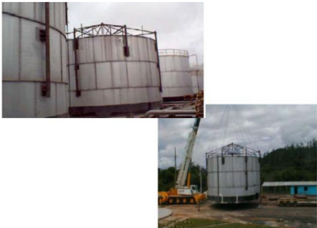
Figura 1-4. Estruturas “soldadas a frio” e tanque sendo assentado ao novo local (da SILVA, A., 2007).
