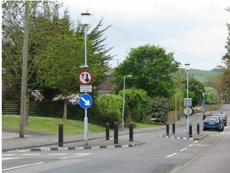
Figura 27: Chicana na estrada para o Castelo de Edimburgo, no Reino Unido. Fonte: Charlesworth (2010)
