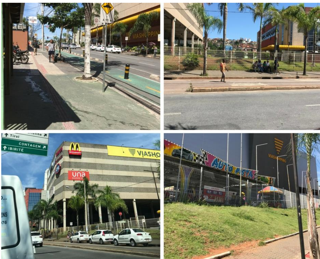
Figura 66: Avenida Afonso Vaz de Melo Fonte: Elaborado pela autora
