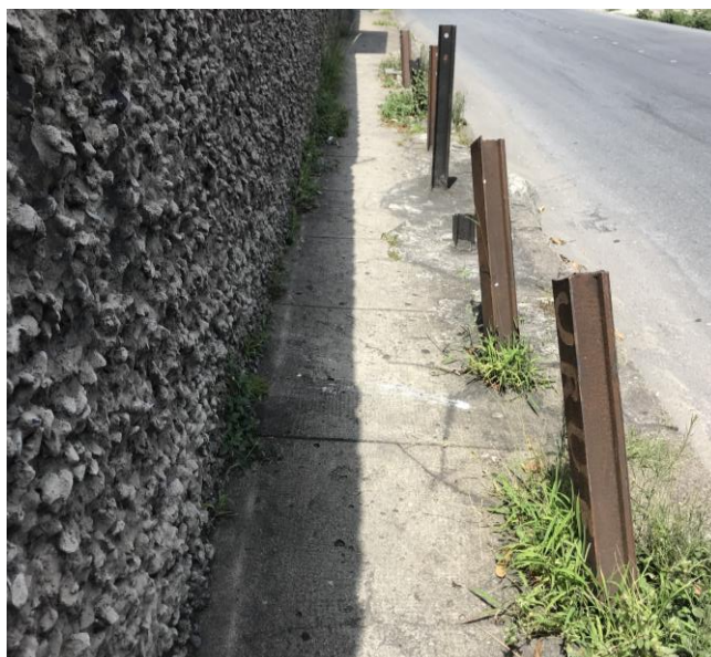
Figura 125: Exemplo de barreira de proteção
