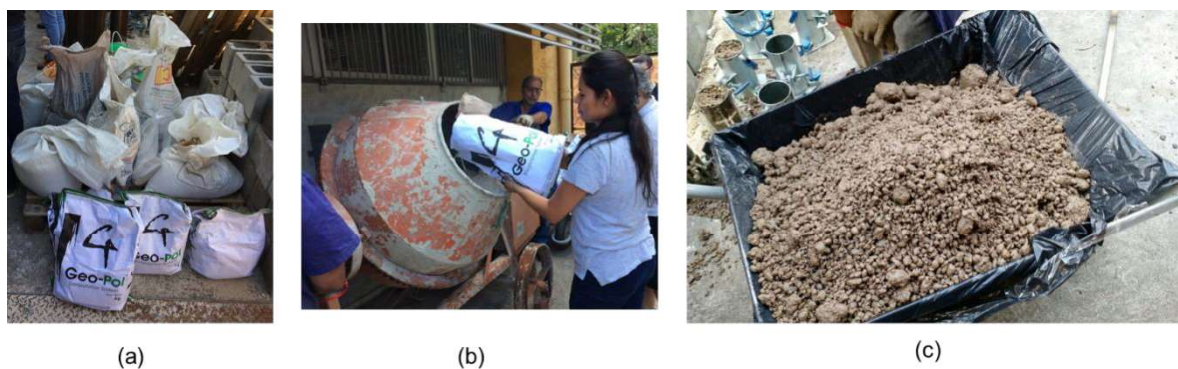
Figura 4.7 - Concretagem dos perfis preenchidos com o concreto geopolimérico I: a) material utilizado; b) mistura; c) concreto fabricado. Fonte: Autor.
