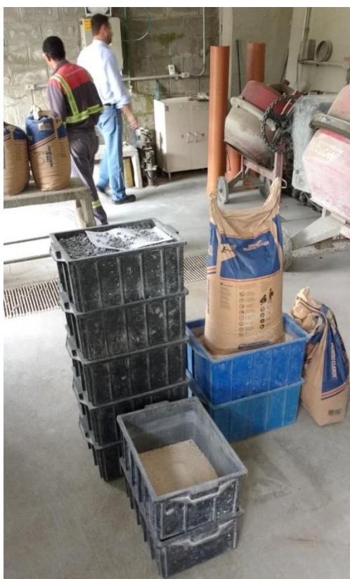
Figura 4.4 - Materiais devidamente medidos em massa, para a mistura, 2017.
