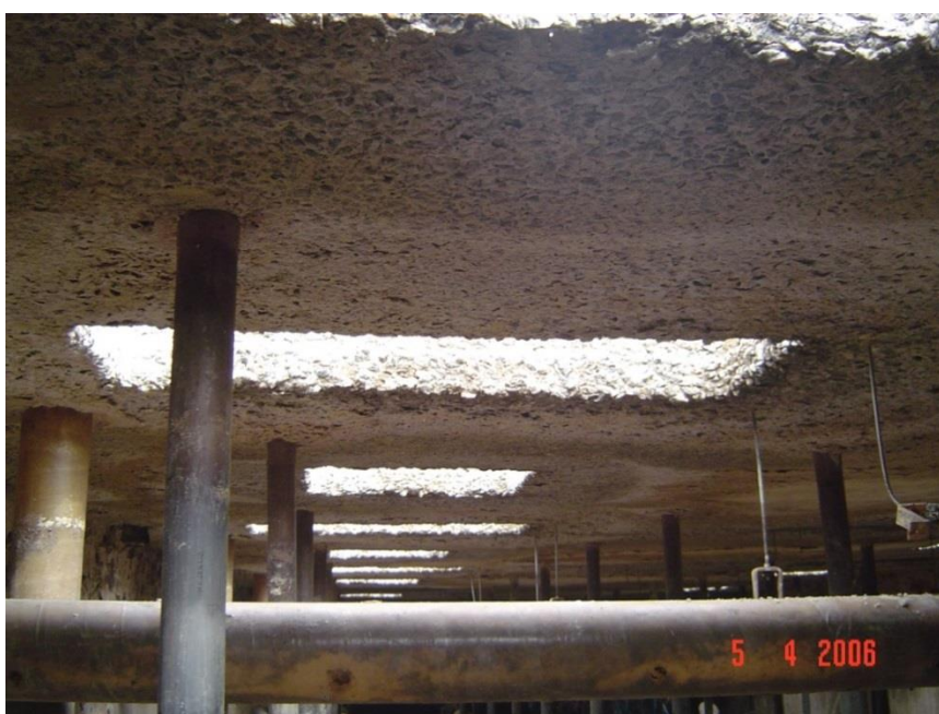
Figura 5.20 - Superfície agredida por biogás, 2016.
