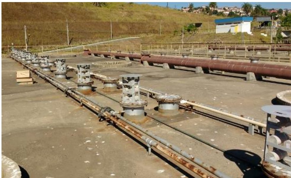
Figura 4.17 - Suportes com os corpos de prova posicionados sobre os pontos de inspeção e coleta do biogás, previamente à sua instalação, 2017.
