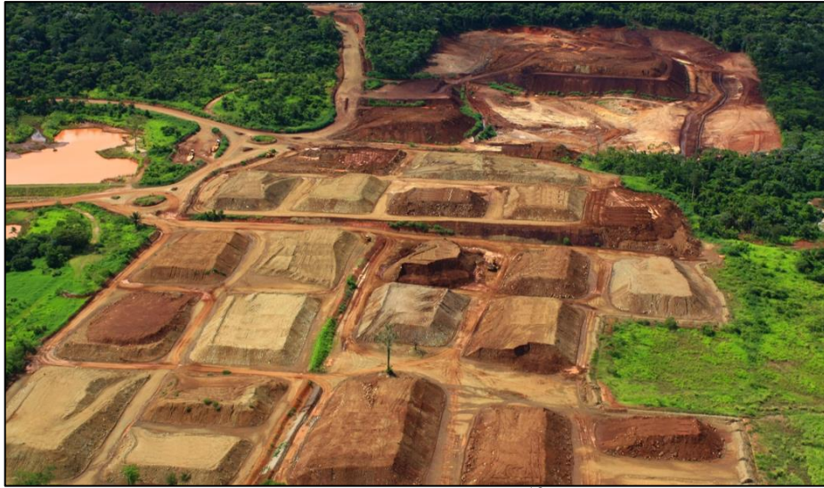
Figura 4 – Pilhas intermediárias de estoque de material
