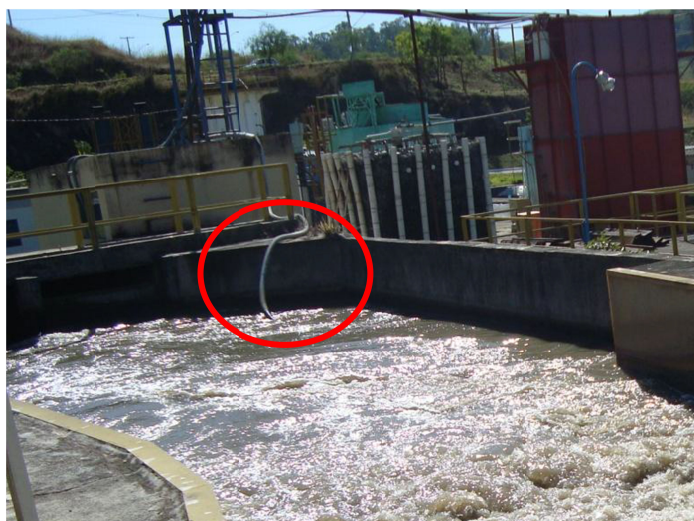
Figura 4.2. Ponto de captação do esgoto
