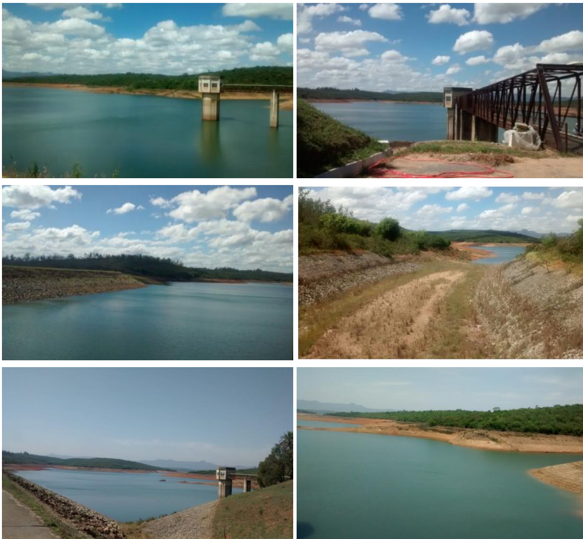
Figura 1A.1 – Corpo d'água, torre de tomada d'água, barragem, vertedouro de soleira livre e rebaixamento do nível d'água no reservatório Serra Azul.
