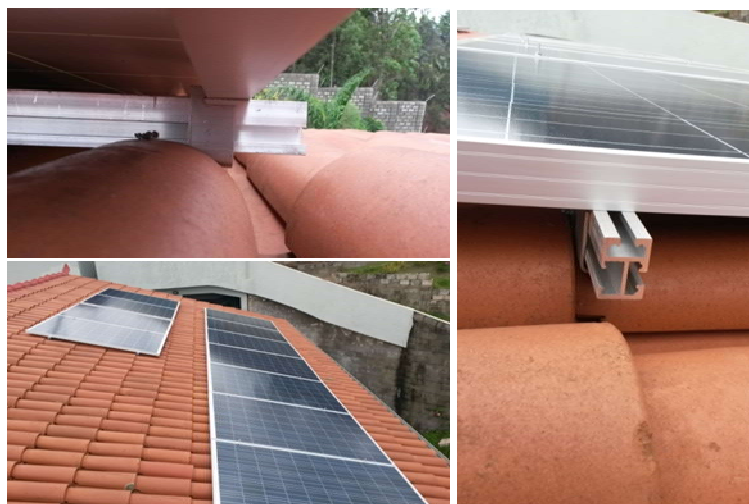
Figura 4-4 - Detalhes de fixação do suporte dos módulos.
