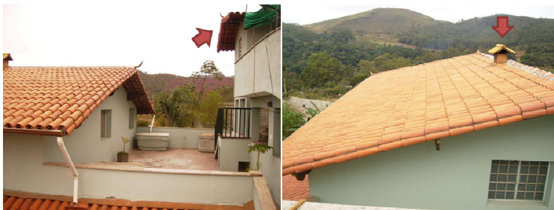
Figura 4-5 - Possíveis fontes de sombreamento do arranjo fotovoltaico.
