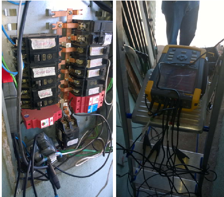
Figura 4-11 – Montagem do analisador de energia.
