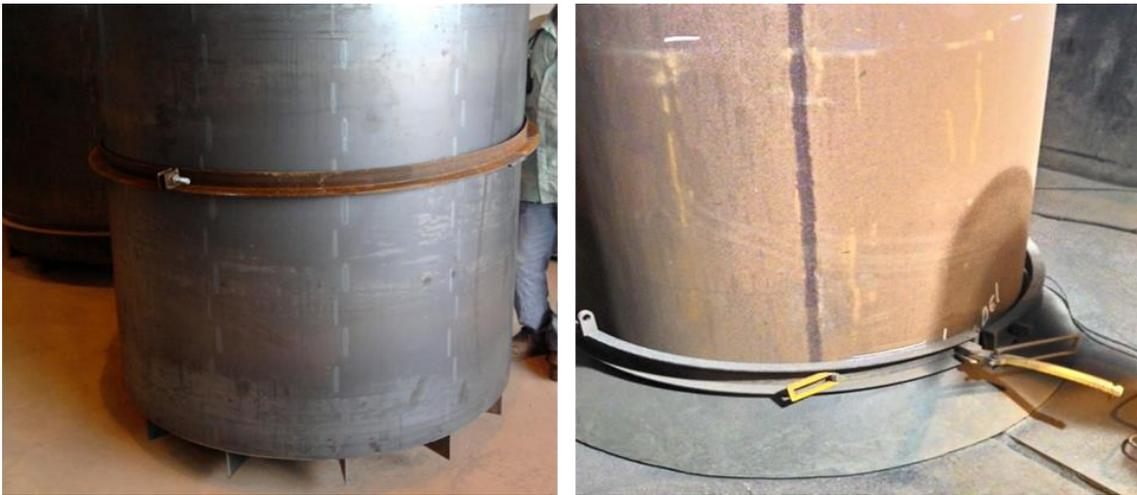
*Figura 20 - O anel antigo, à esquerda, necessitava de três a quatro pessoas para ser montado, além dos desperdícios já citados. A nova ferramenta, à direita, trouxe ganhos financeiros, ergonômicos e de segurança. Fonte: primeira foto cedida do acervo do primeiro pesquisador e segunda foto tirada pelo autor em visita a campo.*
