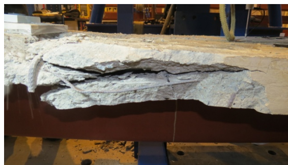
(c) borda da laje (vista posterior)
