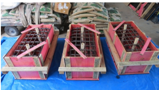
(a) fôrma e armação
