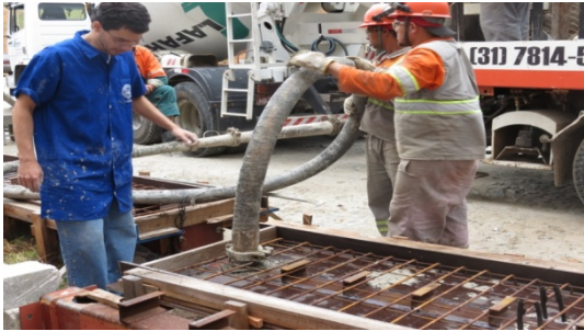
(a) injeção do concreto sob pressão no interior do tubo
