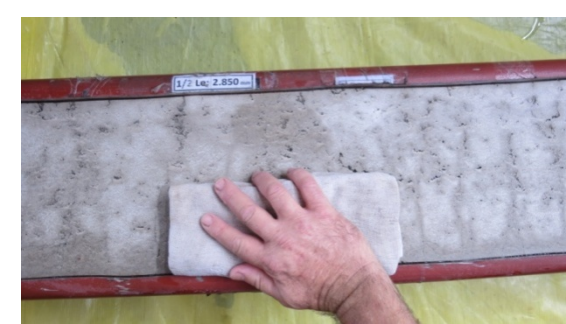
(f) reforço da umidificação das fissuras
