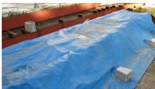
Figura 5.23 – Ensaio de flexão: proteção da fôrma e da armação da laje contra as intempéries
