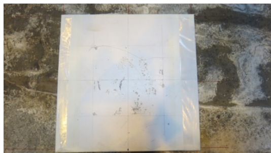
(f) chapa de aço assentada e nivelada
