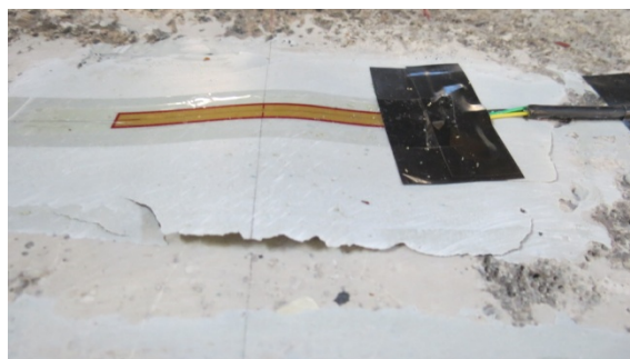
(d) extensômetro próximo ao tubo de aço
