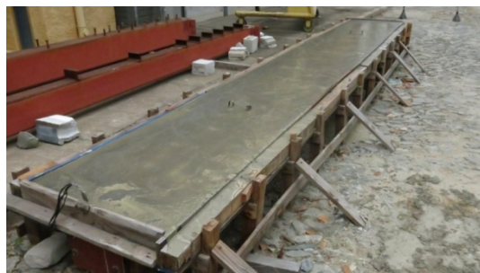
(f) término da concretagem
