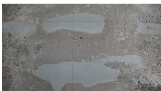
(g) superfície preparada e marcação
