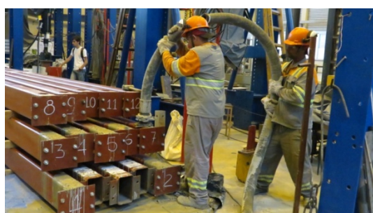
(c) injeção do concreto sob pressão
