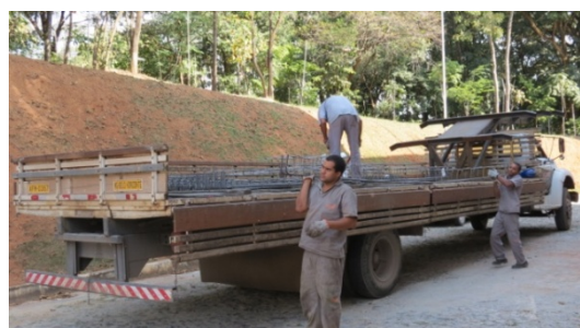
(b) descarregamento das armações
