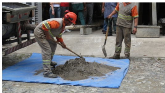
(c) preparação da nata de concreto
