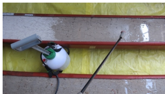
(b) aspersão de água em viga mista sem laje colaborante
