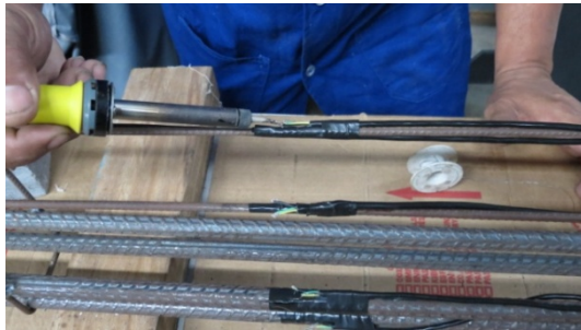
(c) soldagem do cabo aos terminais
