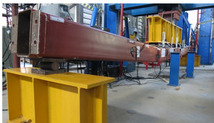
Figura 6.8 – Resultados experimentais: ensaio de flexão de viga de aço
