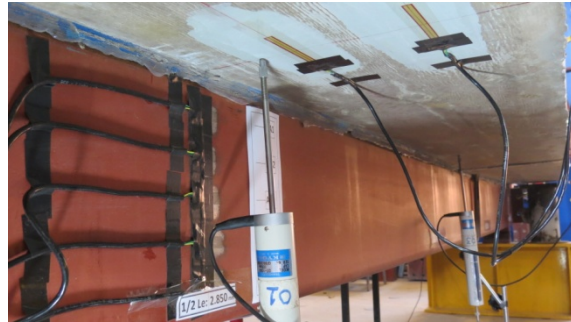
(b) face inferior da laje
