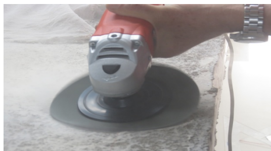
(a) desbaste por lixamento mecanizado
