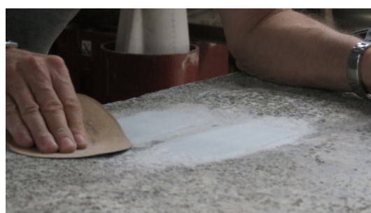
(f) acabamento por lixamento manual
