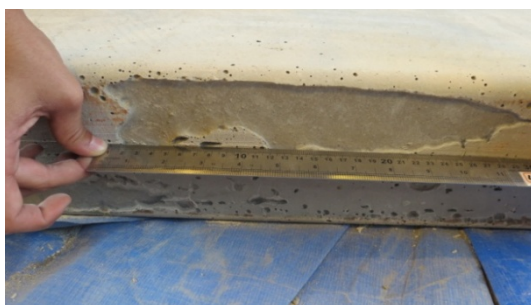
(a) concretagem sem pressão
