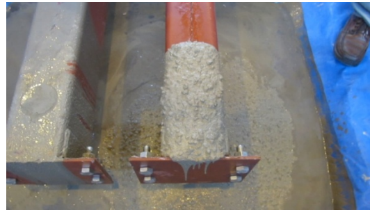
(b) concretagem com pressão
