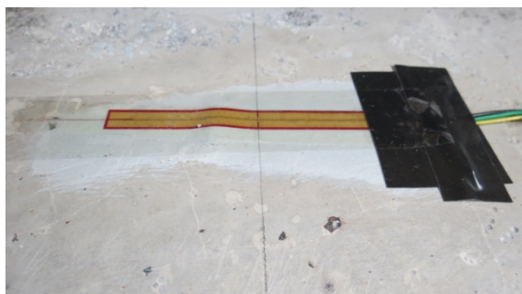
(c) extensômetro próximo ao tubo de aço (antes da remoção da película de massa plástica)
