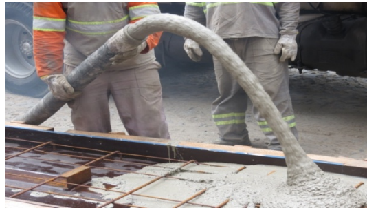
(d) concretagem da laje – fase intermediária
