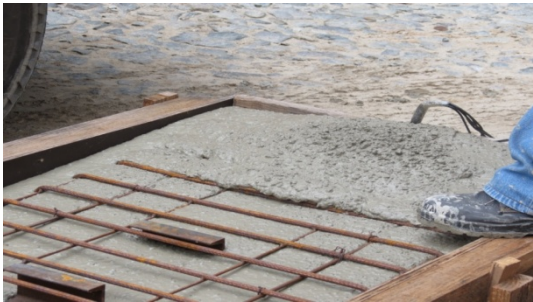
(c) concretagem da laje – fase inicial
