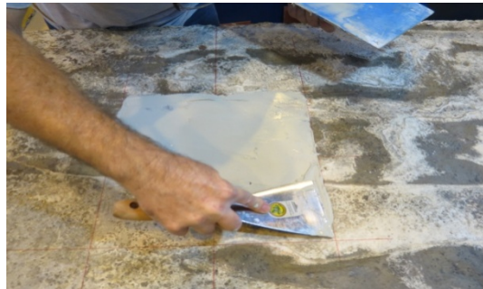
(d) aplicação da massa plástica
