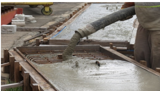
(e) concretagem da laje – fase final
