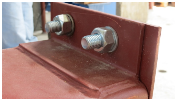
(f) sistema de fechamento das extremidades (detalhe)
