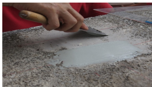
(d) aplicação da massa plástica
