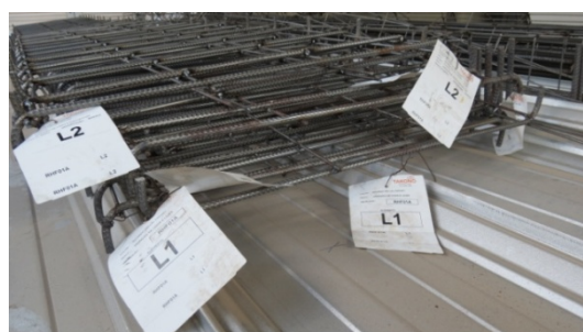
(d) armações da laje de concreto
