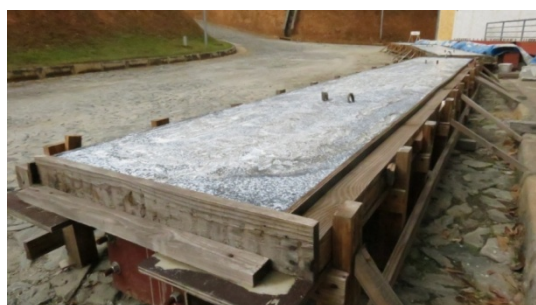
(c) cura química: filme fino ou membrana de cura
