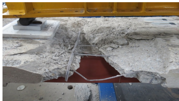
(f) vista posterior após remoção das placas de concreto
