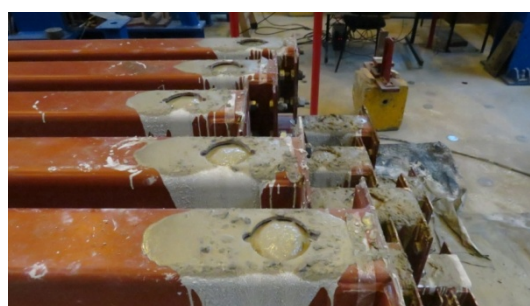
(d) término da concretagem
