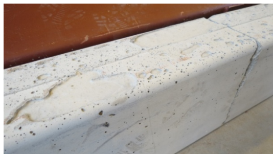
(b) concretagem com pressão
