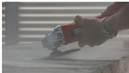
(b) aplainamento mecanizado
