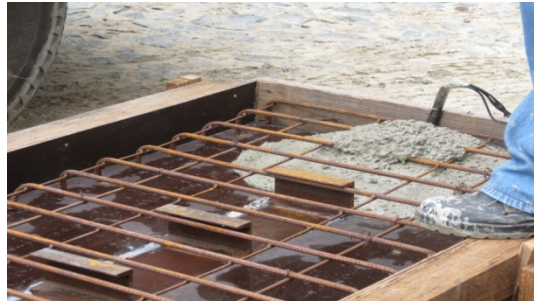
(b) saída do concreto após o preenchimento do tubo
