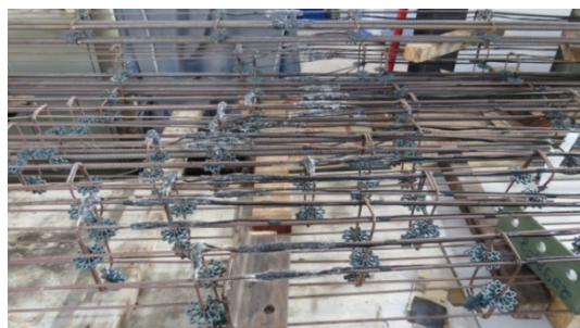
(b) instalação dos espaçadores
