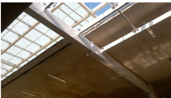
Figura 1.6 - Cobertura do aeroporto Tancredo Neves, MG, Brasil
