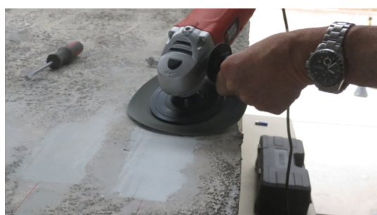
(e) acabamento por lixamento mecanizado
