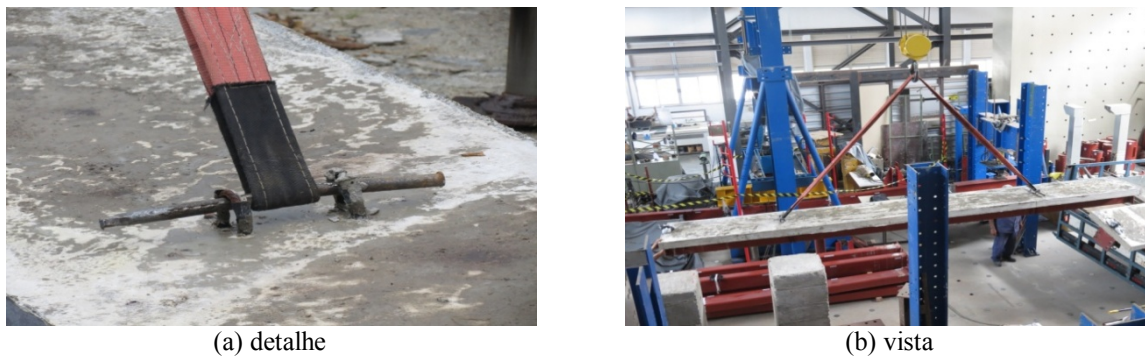
Figura 5.21 – Ensaio de flexão: içamento das vigas mistas com laje colaborante
