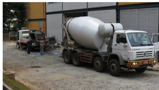
(b) caminhão betoneira
