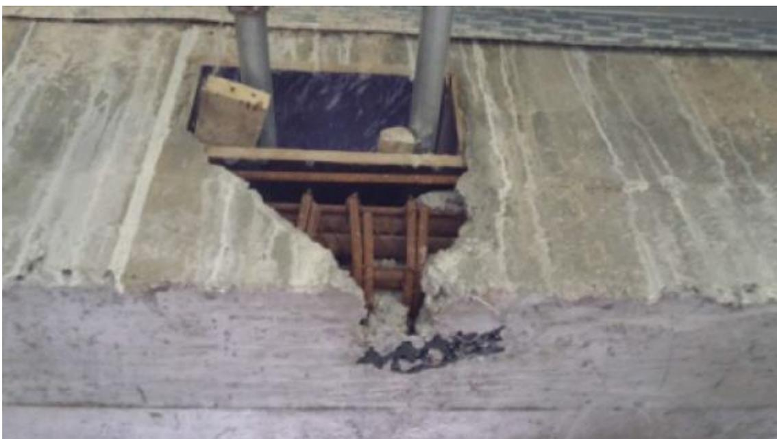
Figura 1 - Má concretagem em região de furos
