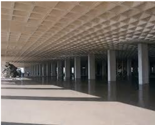
Figura 3 – Laje Nervurada
