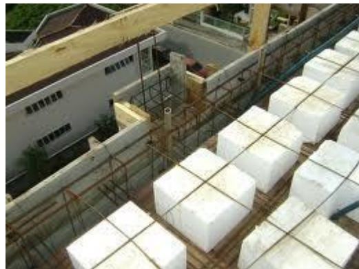
Figura 4 – Armação Laje Nervurada
