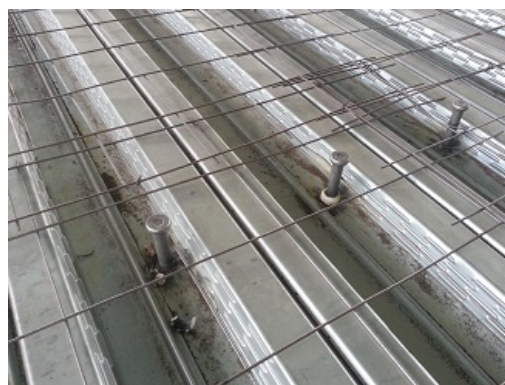
Figura 1.2: Conectores de cisalhamento
