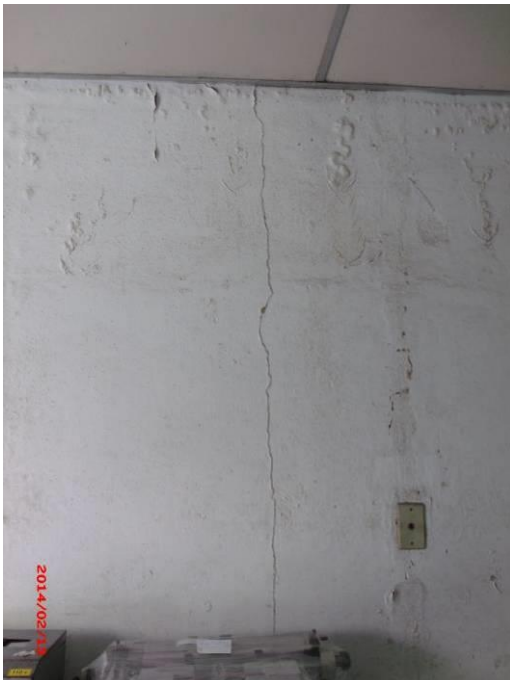
Figura 4.10 - Trinca na vertical em toda extensão do pé direito - medição da espessura com fissurômetro.
