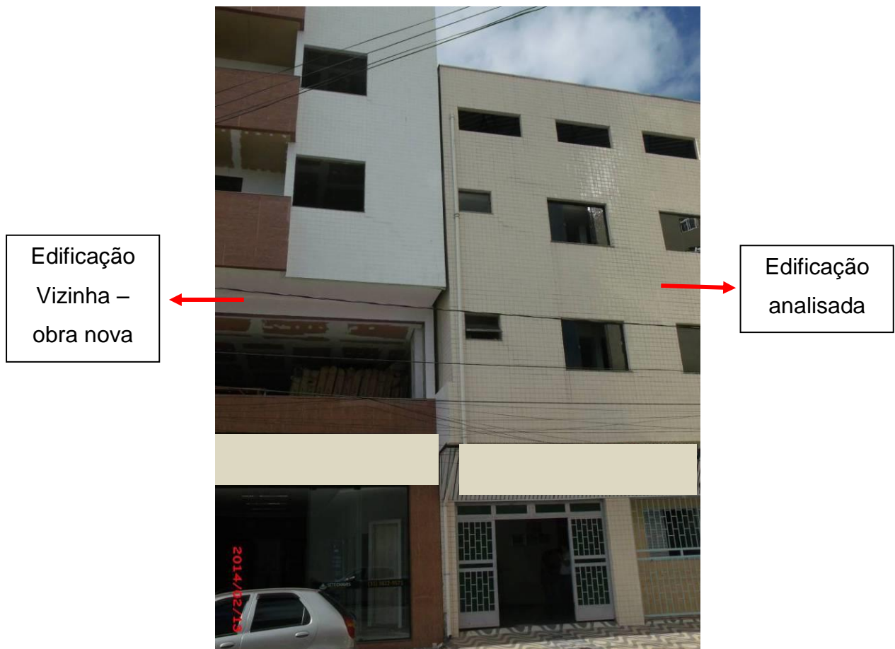
Figura 4.1529 - Posição edificação analisada e edificação vizinha (obra nova).
