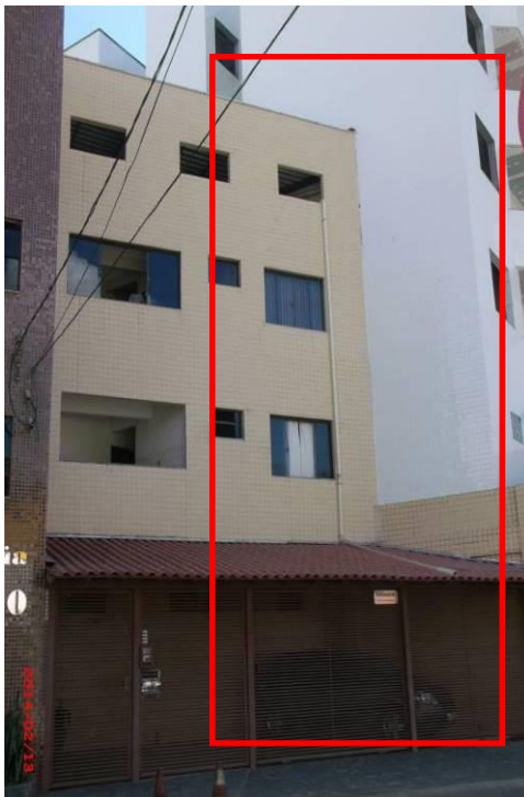
Figura 30 - Edificação da contratante e edificação vizinha, sem junta de dilatação.
