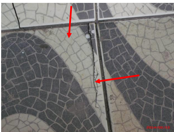
Figura 4.1428 - Rachaduras no piso.
