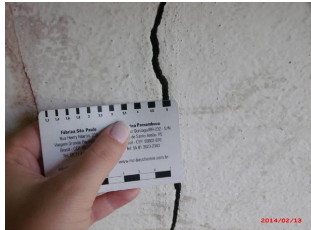
Figura 4.7 - Rachadura na área interna, medição da espessura com fissurômetro.
