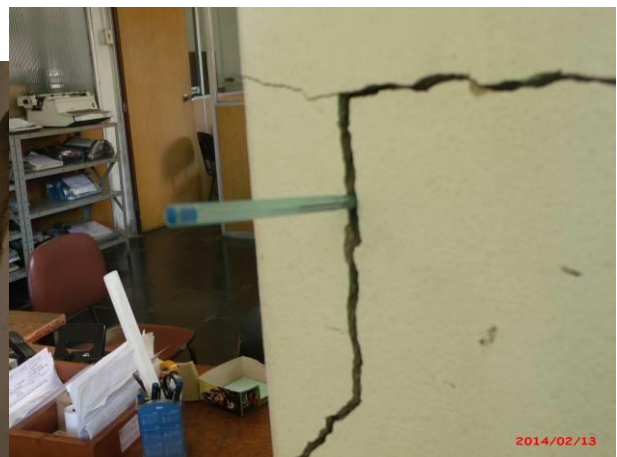
Figura 23 - Rachadura na área interna da edificação.
