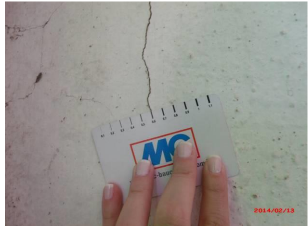
Figura 4.924 – Trincas na diagonal - medição da espessura com fissurômetro.
