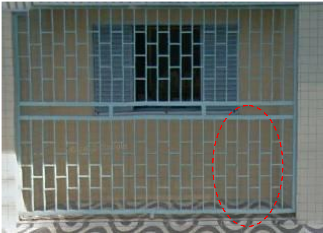
Figura 4.4 - Fachada da edificação anterior a construção da edificação vizinha, em 2011. Fonte: Google Earth, 2011
