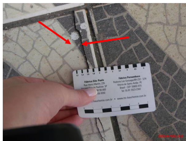
Figura 4.1428 - Rachaduras no piso.
