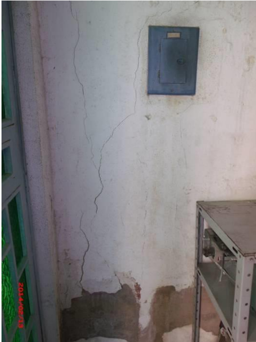
Figura 4.924 – Trincas na diagonal - medição da espessura com fissurômetro.
