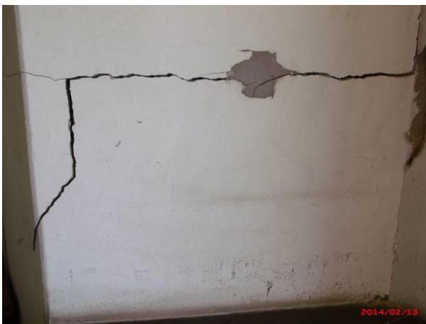
Figura 23 - Rachadura na área interna da edificação.
