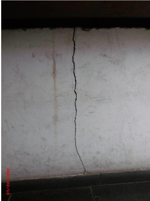
Figura 4.7 - Rachadura na área interna, medição da espessura com fissurômetro.
