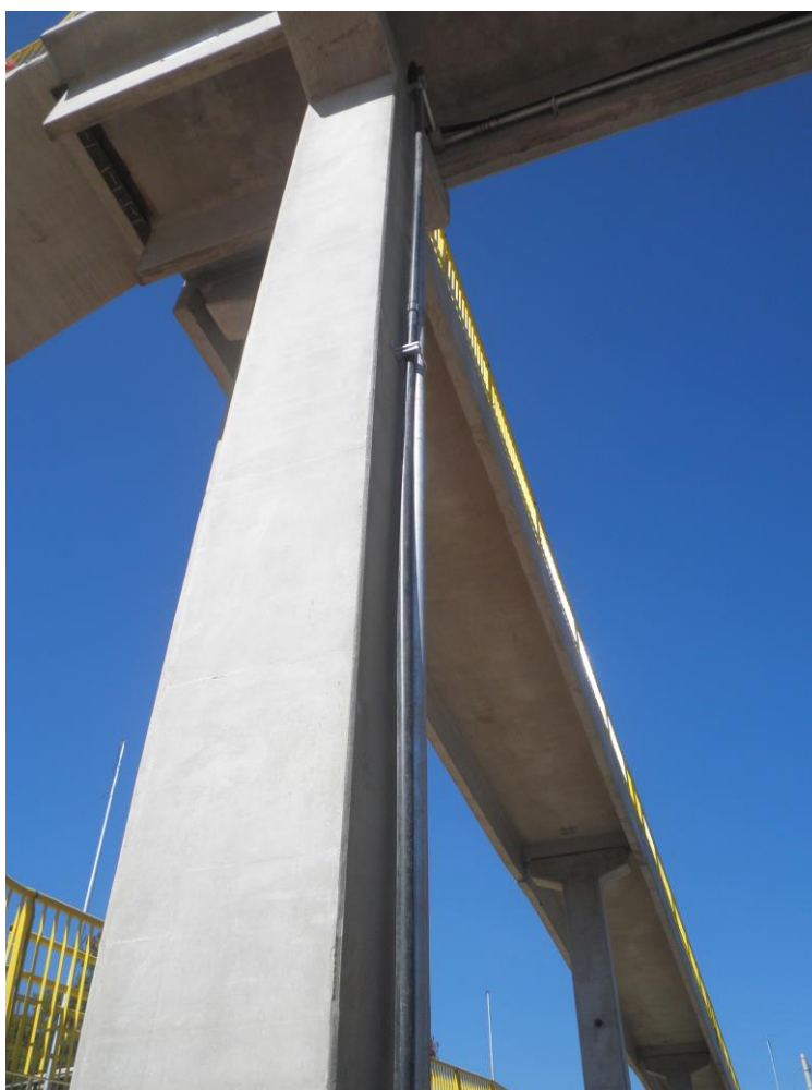
Figura 24 – Falha de fluxo errático da execução de tubulação elétrica.
