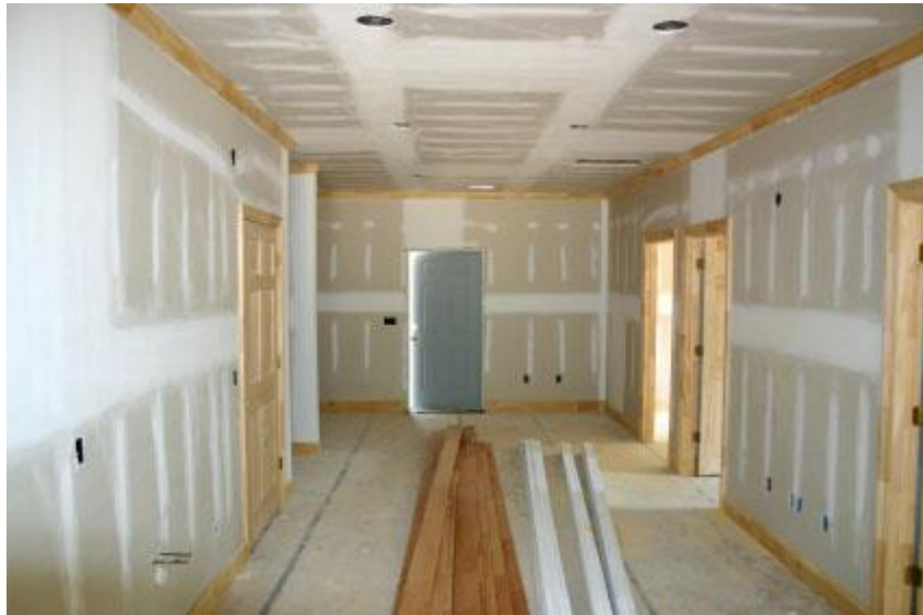
Figura 10 – Exemplo de flexibilidade – uso de Dry Wall.
