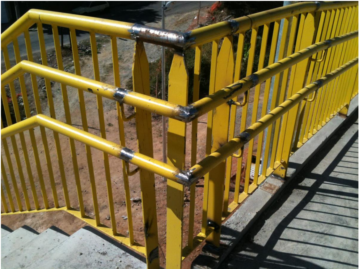
Figura 21 – Recortes de peças de gradis não previsto.
