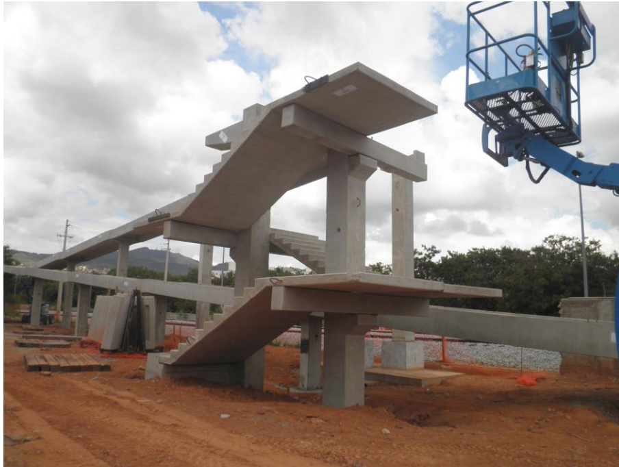
Figura 9 – Elementos pré-moldados – redução de etapas no processo produtivo.
