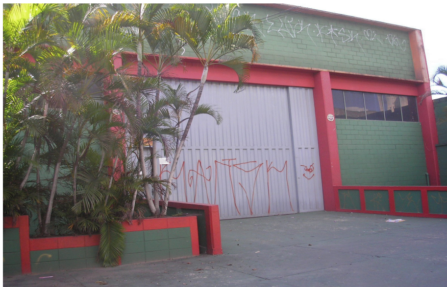
Figura 6.6 – Imóvel Comercial – 1493,25 m 2
