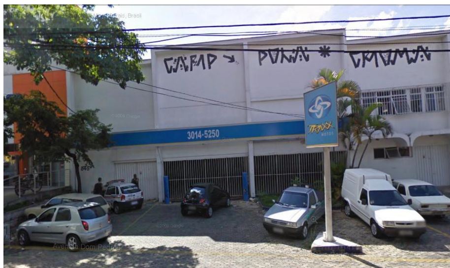
Figura 6.2 – Galpão Comercial – 556,25 m 2
