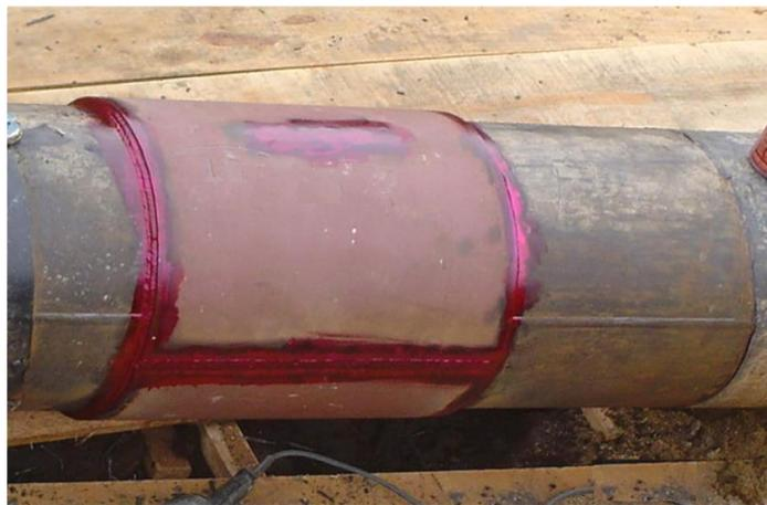
Figura 21: Luva bipartida tipo B instalado em um mineroduto [9].
