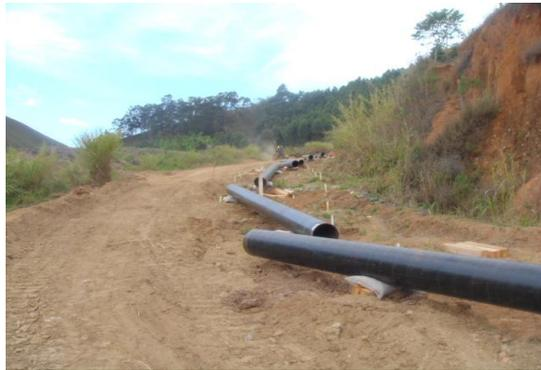
Figura 2: Serie de tubos desfilados para construção de mineroduto [9].
