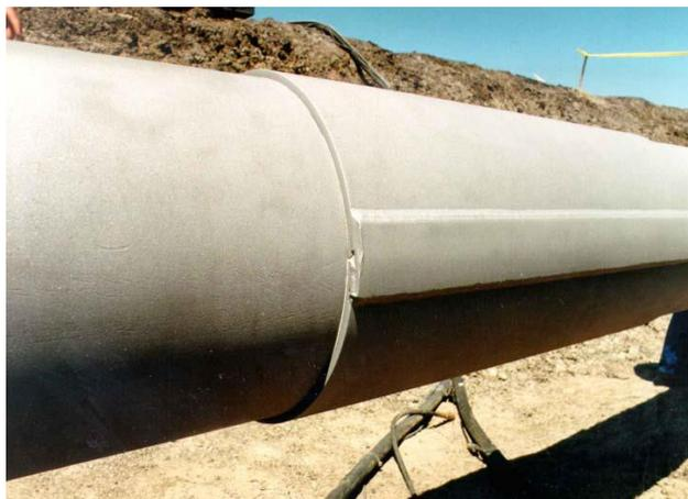
Figura 19: Luva bipartida tipo A com chapa lateral de sobreposição [14].
