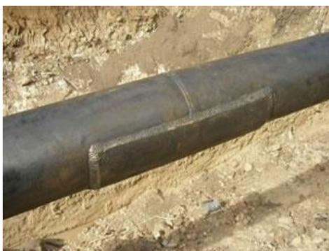
Figura 29: Chapa de reforço estrutural soldada em um gasoduto [25].
