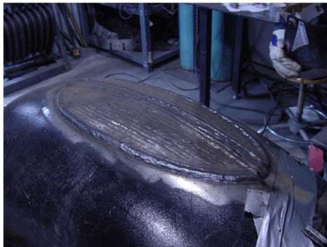
Figura 25: Reparo interno de um cotovelo realizado com deposição externa de solda [20].
