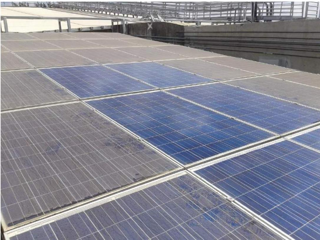
Figura 21: Comparação visual entre módulos limpos e sujos.
