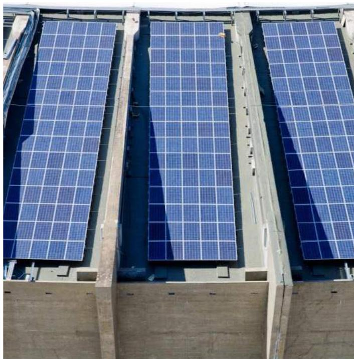
Figura 19: Módulos Fotovoltaicos da Usina Mineirão com destaque para as áreas sombreadas.
