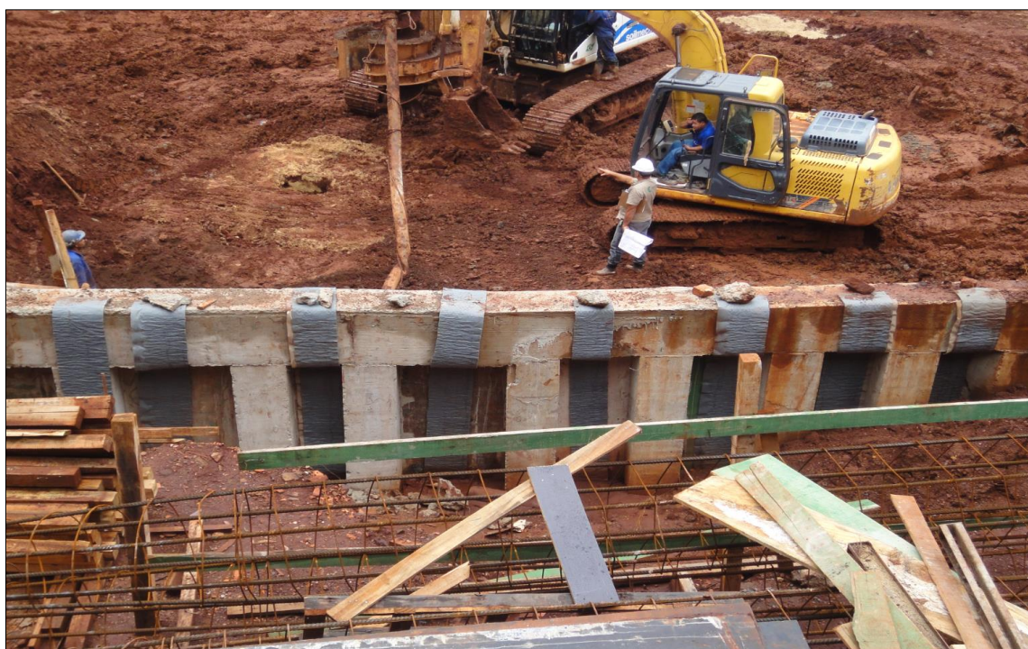
Figura 5.9 – Foto das Estacas de Contenção
