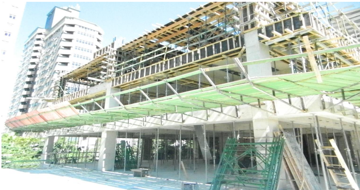
Figura 5.21 – Foto da Estrutura do Prédio no 7º Pavimento – Empreendimento 1
