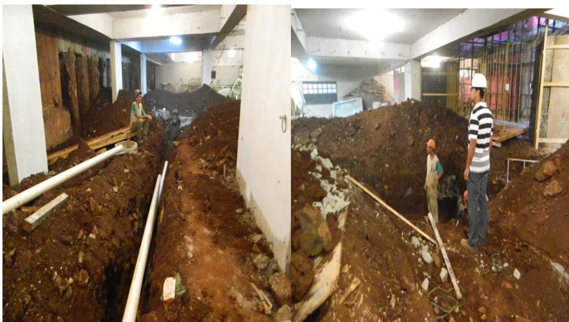
Figura 5.22 – Foto do Subsolo do Prédio – Empreendimento 1
