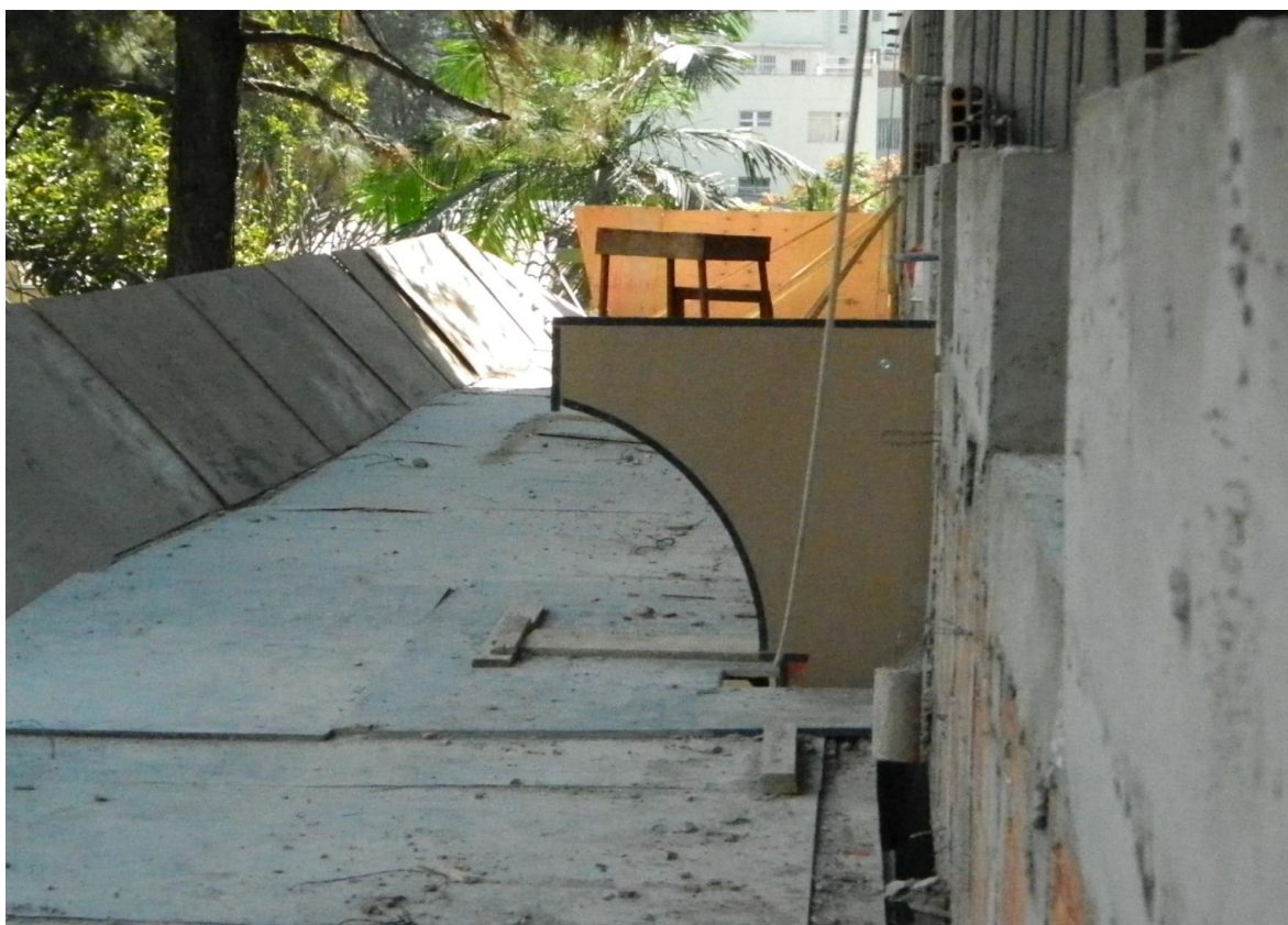
Figura 5.12 – Foto do Molde da Moldura da Fachada
