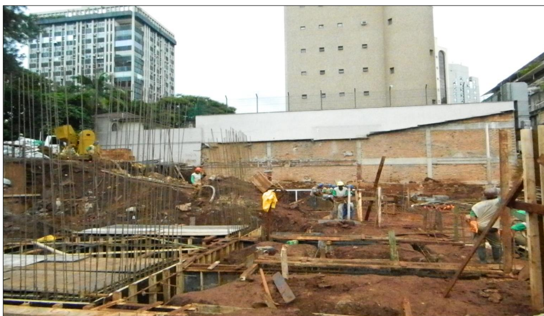
Figura 5.11 – Foto dos Blocos de Fundação do Poço dos Elevadores
