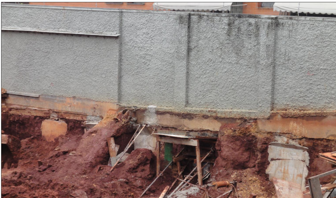
Figura 5.10 – Foto do Reforço da Fundação do Muro do Vizinho
