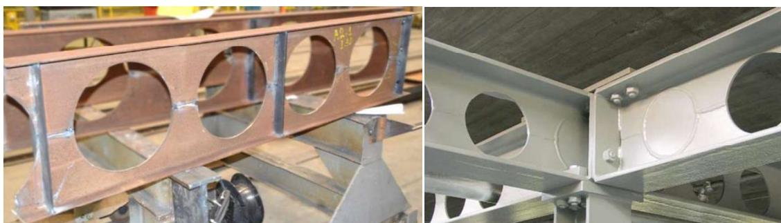
(a) Viga celular com enrijecedores transversais (b) Fechamento de alvéolo próximo ao apoio
