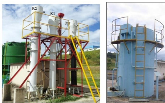
Figura 4-1: Reatores UASB utilizados na presente pesquisa. Esquerda: reatores UASB-piloto e direita: reator UASB demonstração.
