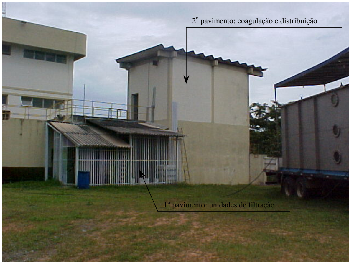
Figura 4.1: Vista do local de implantação da ETA piloto
