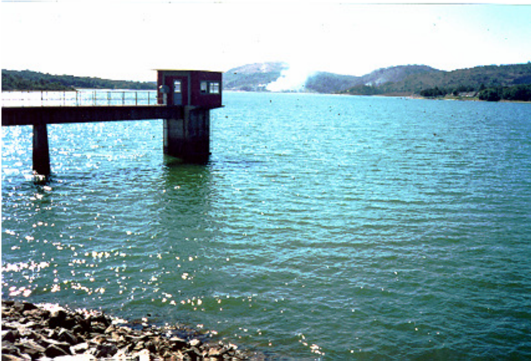
Figura 3.1: Vista da represa Várzea das Flores
