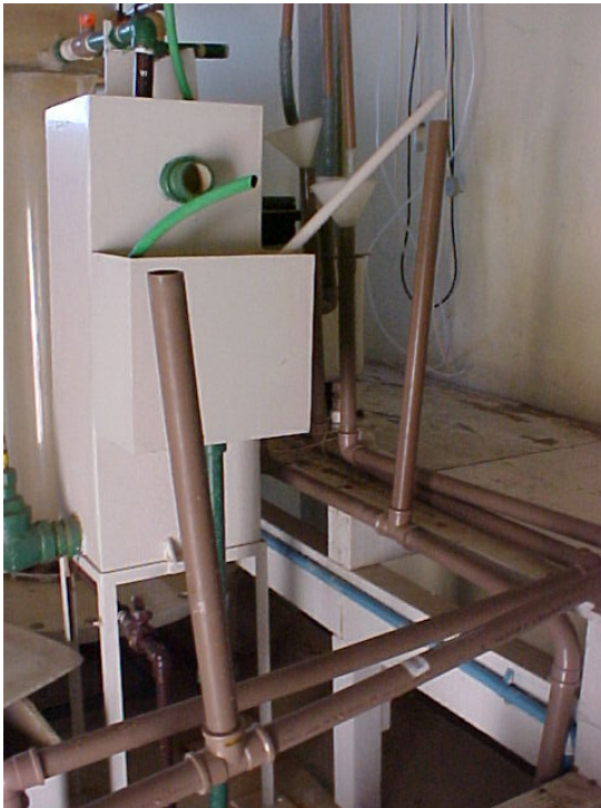
Figura 4.12: Detalhe da solução adotada para a fuga de ar das tubulações adutoras
