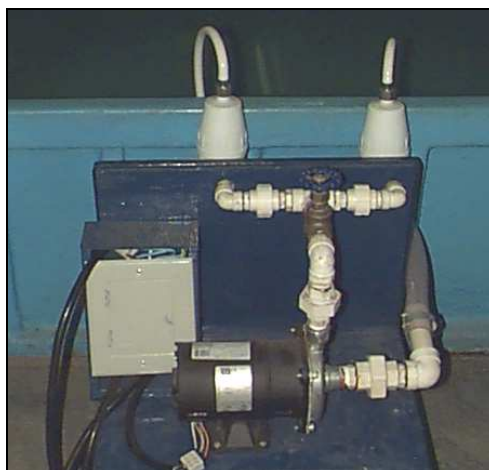
Figura 4.8 – Sistema elétrico de aquecimento de água do aparato de testes. (fonte própria)
