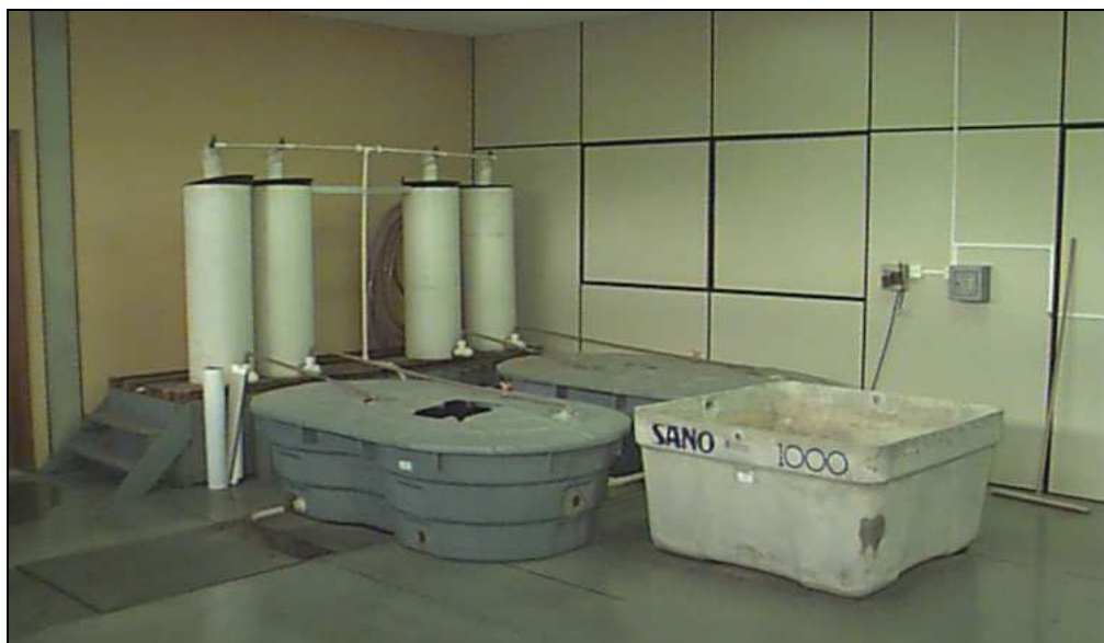
Figura 4.11 – Aspecto dos reservatórios e filtros do sistema de manutenção, onde foram adaptados termostatos e aquecedores elétricos (fonte própria).
