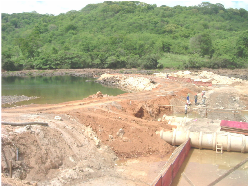
Figura 4.4: Vista da soleira 4
