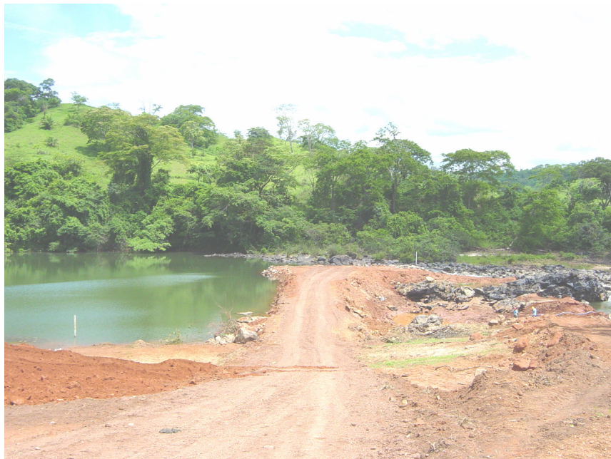
Figura 4.5: Vista da soleira 6
