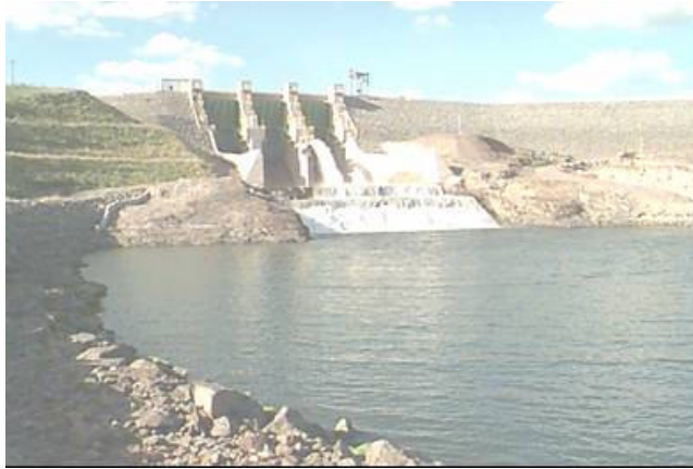
Figura A7: Comportas fechadas e manutenção da vazão através da válvula
