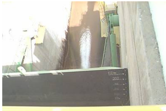
Figura A8: Uma das três comportas praticamente fechada
