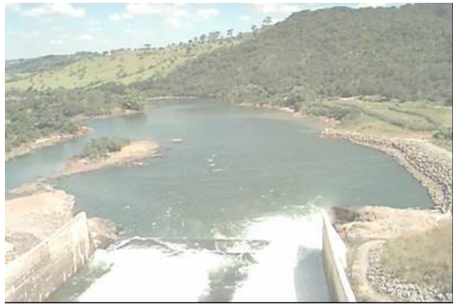
Figura A10: Início do trecho de vazão reduzida (fotografia retirada da barragem, em acima das comportas)
