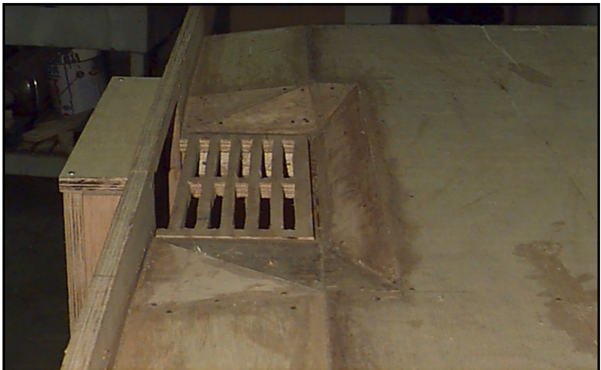
Figura 5.2 – Conclusão dos serviços de marcenaria
