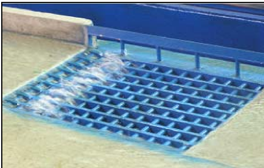
Figura 4.8 – Bocas-de-lobo utilizadas em ruas do Chile
