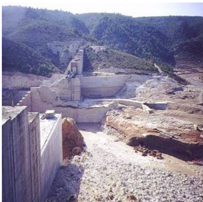
Figura 3.10 – Barragem de Tous após a ruptura (DE CEA, 2006)
