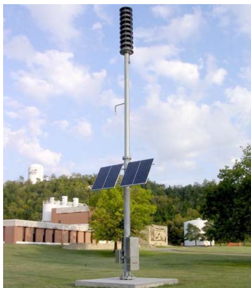
Figura 4.19 – Exemplo de sirene instalada nos Estados Unidos (USACE, 2005)
