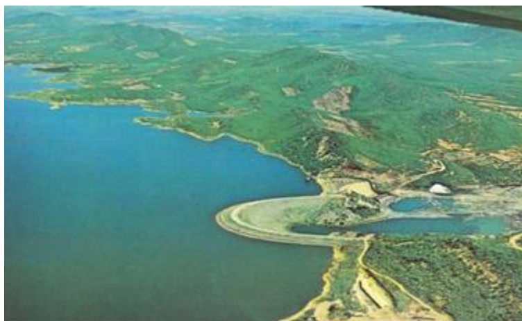
Figura 3.13 – Barragem de Orós após a reconstrução (DNOCS, 2007)
