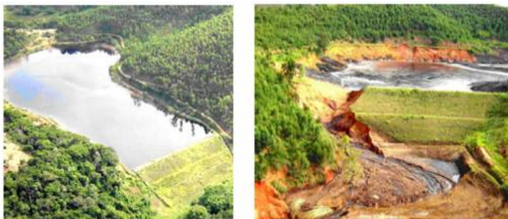
Figura 3.14 – Barragem de Cataguases antes e depois do acidente (MENESCAL et al. , 2005a)
