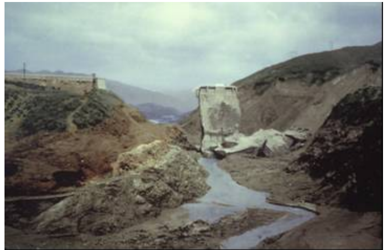
Figura 3.3 – Imagens colorizadas da barragem de St. Francis antes e depois do acidente (ROGER, 2006)
