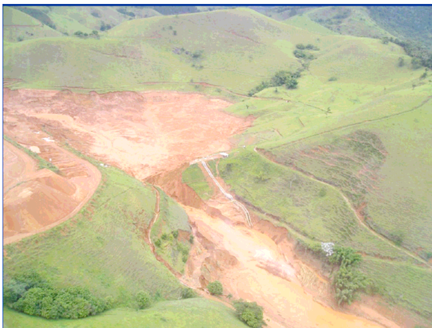
Figura 3.16 – Vista da ruptura da barragem (MENESCAL, 2007)
