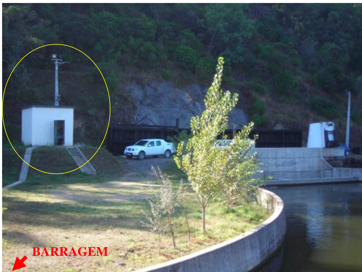
Figura 4.7 - Sala de emergência da barragem de Penacova, em Portugal (BALBI, 2007)
