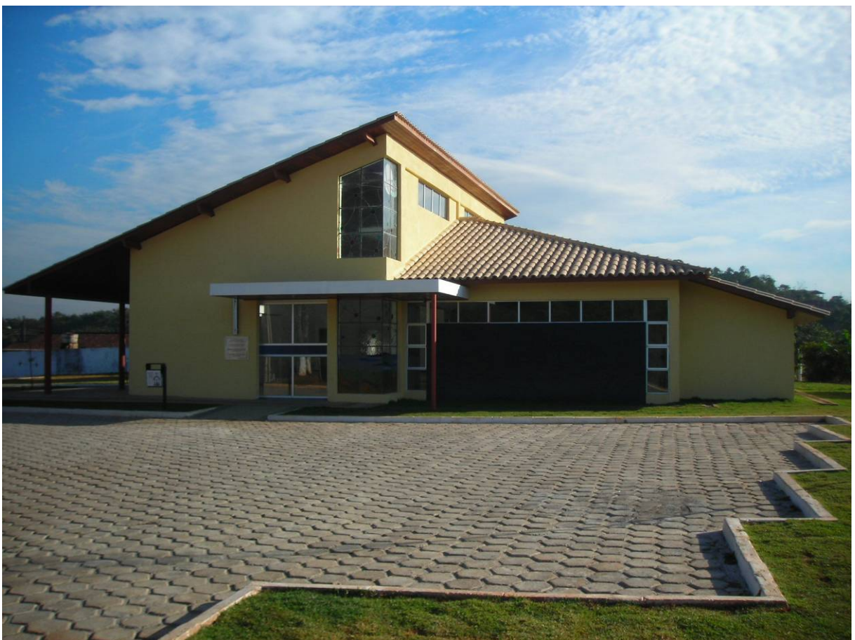
Figura E8 – Velório municipal – possível local de recepção e manejo de mortos
