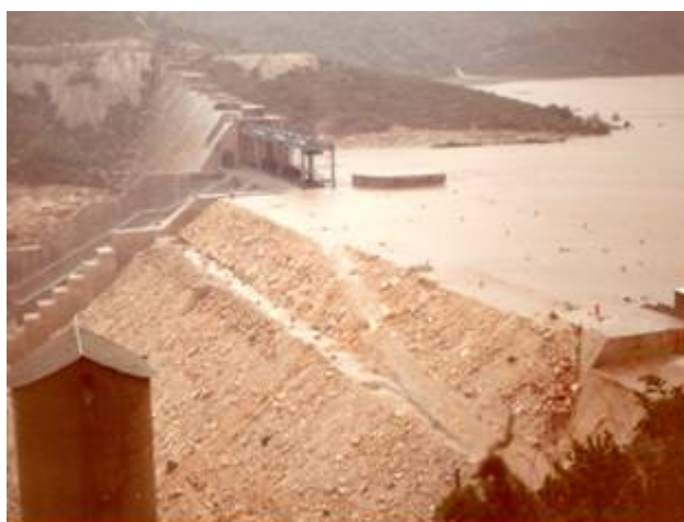
Figura 3.9 – Galgamento da barragem de Tous (DE CEA, 2006)
