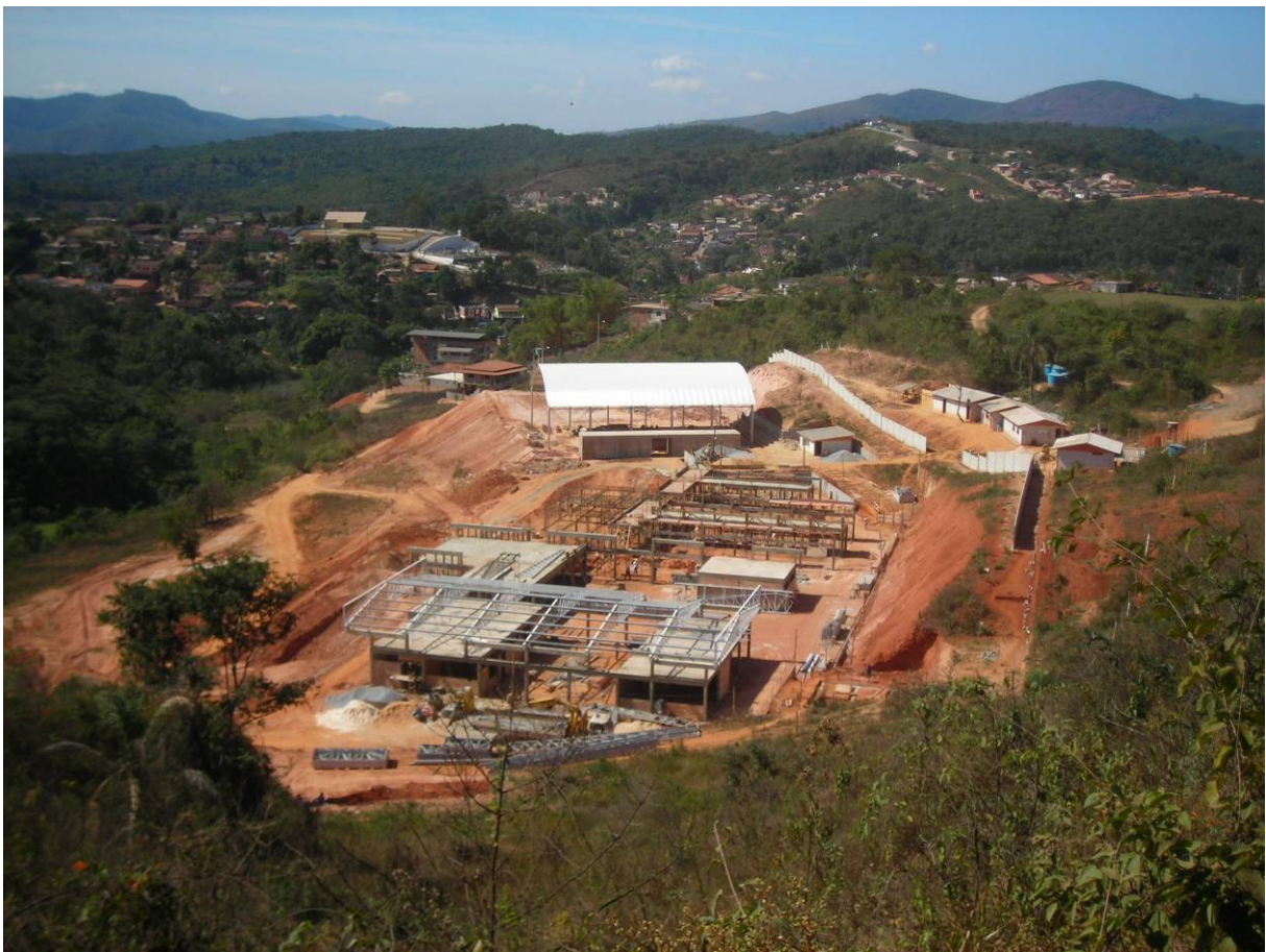
Figura E11 – Implantação da nova escola de período integral – Situação em julho/2007
