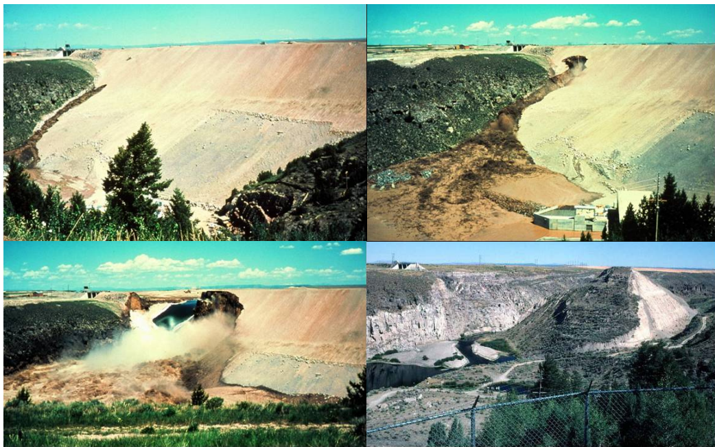
Figura 3.5 – Parte de uma série de fotos da ruptura de Teton e foto do local após o desastre (SYLVESTER, 2007)
