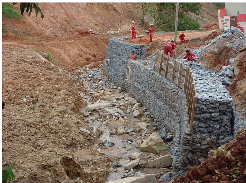
Figura 4.9 - Gabiões utilizados para a contenção de encostas do córrego Mergulhão, Belo Horizonte/ MG (Foto: Rodrigo França).
