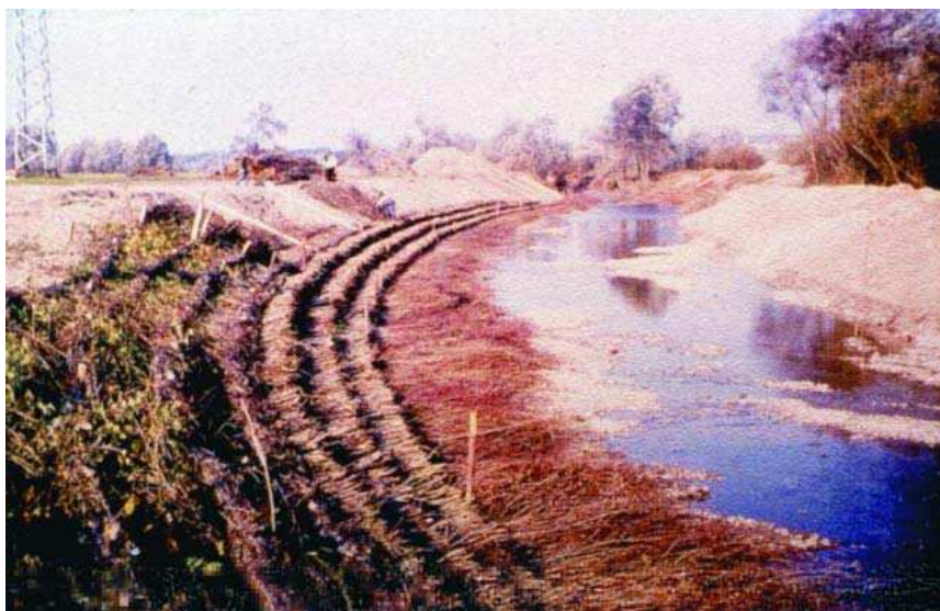
Figura 4.6 – Proteção de margem com instalação de faxinas de salgueiro (Fonte: SELLES, 2001).
