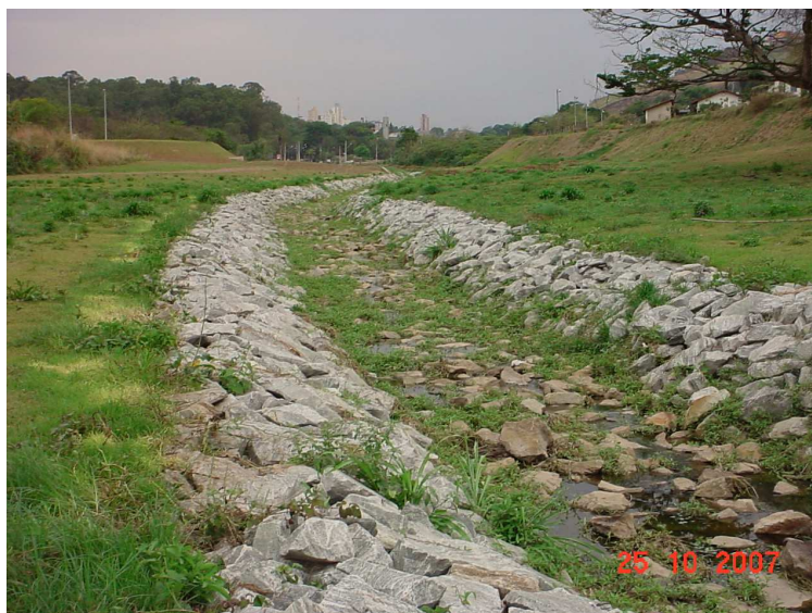
Figura 4.10 – Enrocamento utilizado para revestimento do leito e das margens do córrego Mergulhão – Belo Horizonte/ MG (Foto: Rodrigo França).
