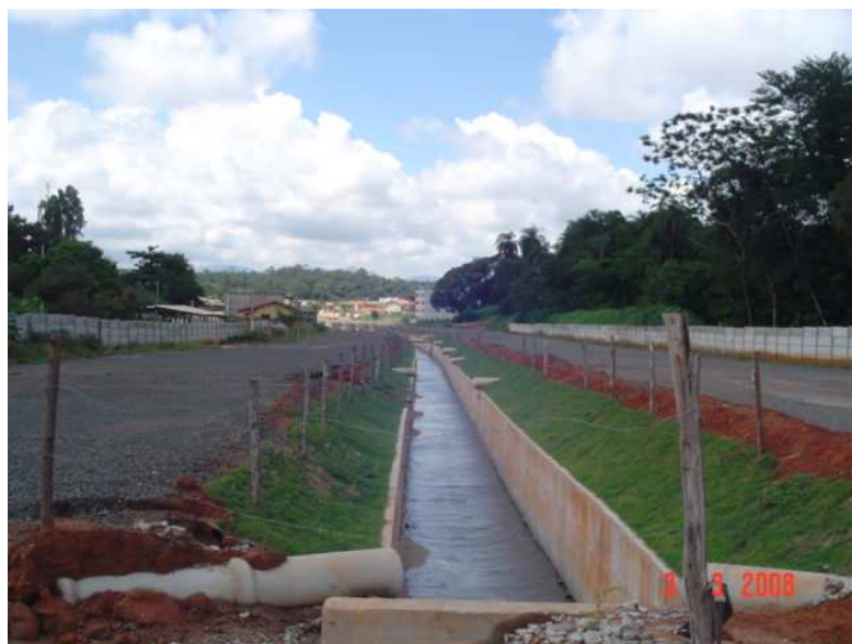
Figura 6.27 – Trecho canalizado do córrego Bom Retiro - de montante para jusante (Foto: Adriana Cardoso).
