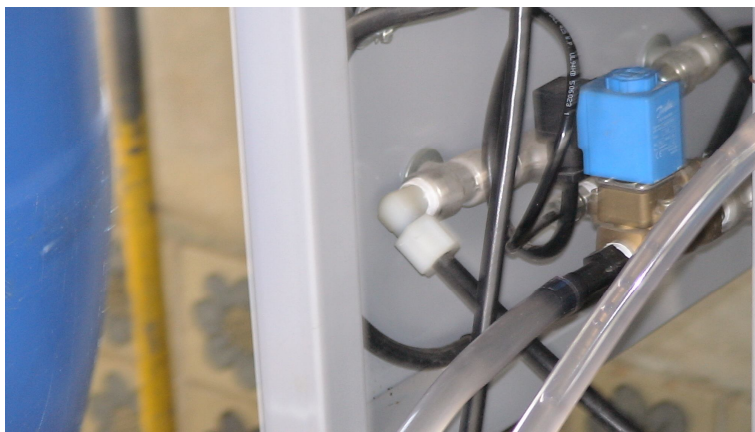
Figura 4-8: Válvula solenóide programada para o flush do sistema.
