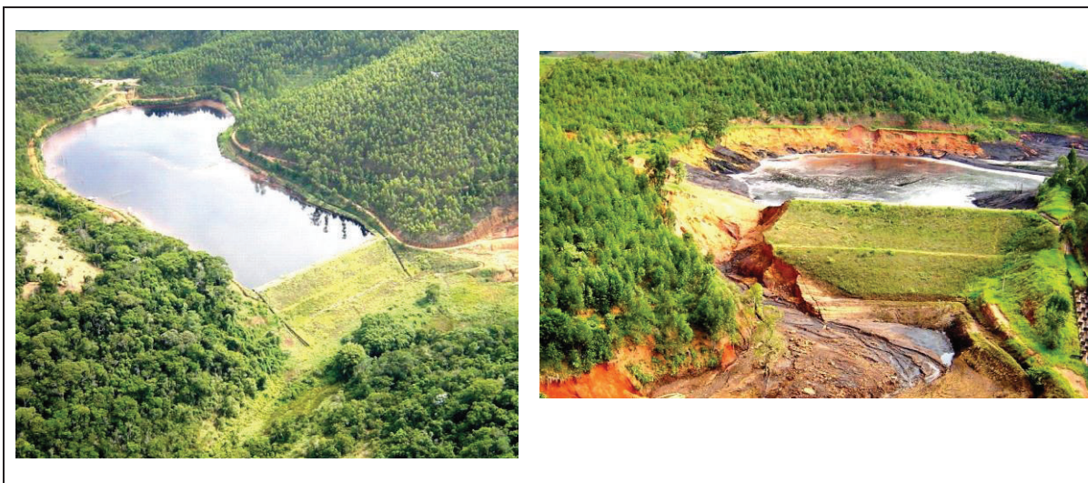
Figura 3.16 – Vista da barragem de rejeitos da Indústria Papel Cataguases antes e depois da ruptura
