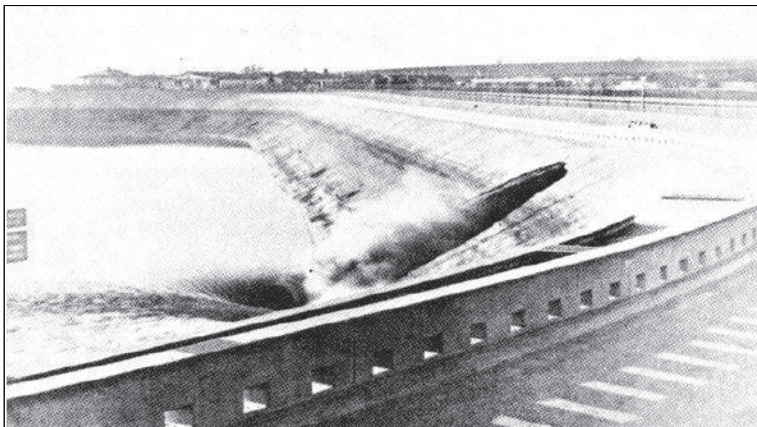
Figura 3.9 – Ruptura da barragem Baldwin Hills, com vista da brecha parcialmente formada às 15:30 h
