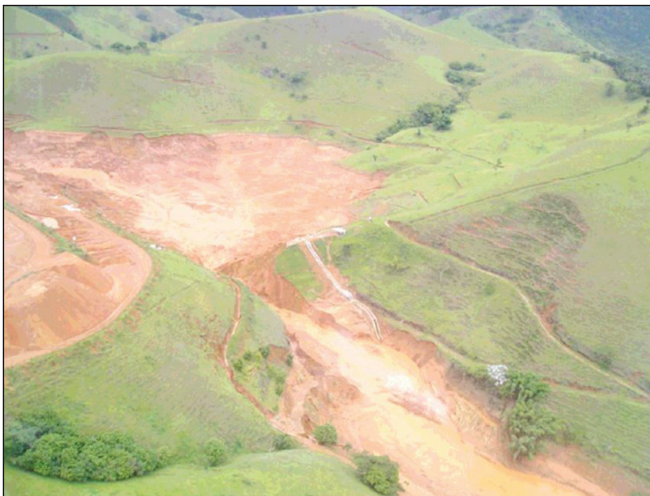
Figura 3.18 – Vista da barragem de rejeitos da mineração Rio Pomba, após ruptura Fonte: MENESCAL, 2007
