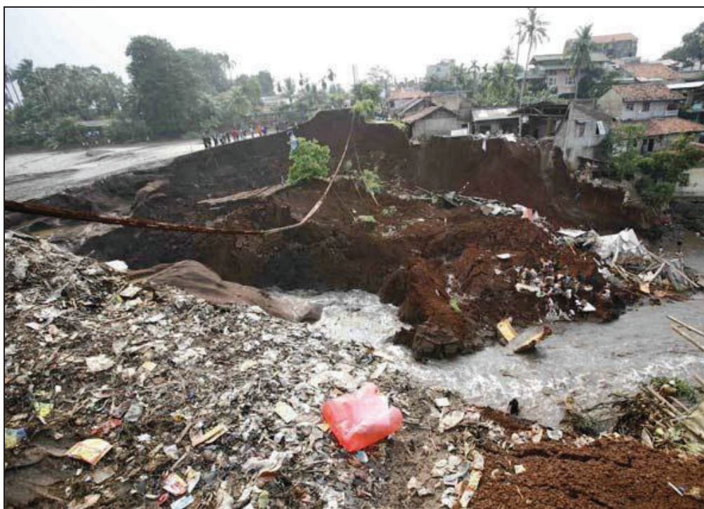
Figura 3.21 – Vista da barragem Situ Ginung após a ruptura
