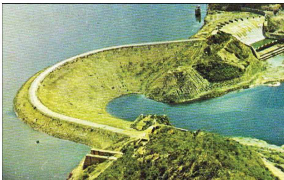
Figura 3.7 – Vista da barragem de Orós após o término de sua reconstrução
