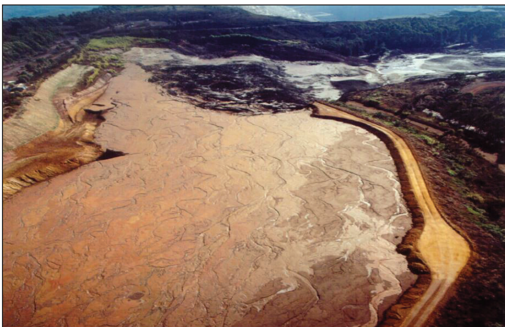
Figura 3.15 – Vista da barragem de rejeitos da mineração Rio Verde após a ruptura Fonte: ÁVILA, 2008
