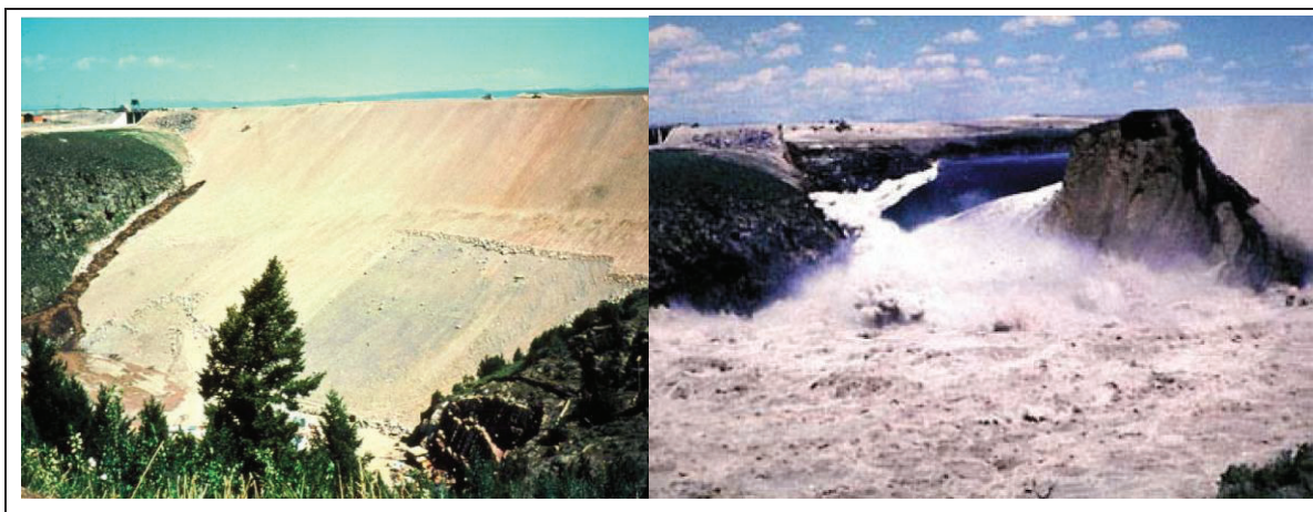
Figura 3.11 – Vista do maciço da barragem de Teton, indicando o início e o final do processo de formação da brecha de ruptura
