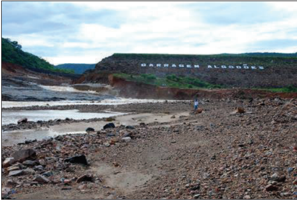
Figura 3.22 – Vista do maciço da barragem Algodões I após a ruptura
