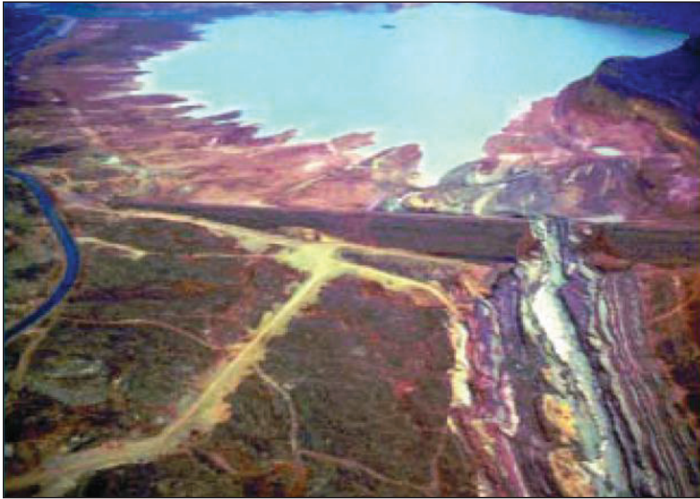
Figura 3.14 – Vista área da barragem de Quail Creek após a ruptura
