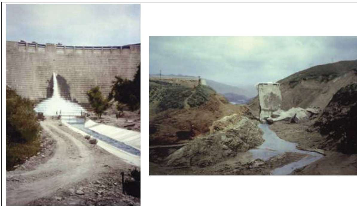
Figura 3.4 – Vista da barragem de St. Francis antes e depois da ruptura
