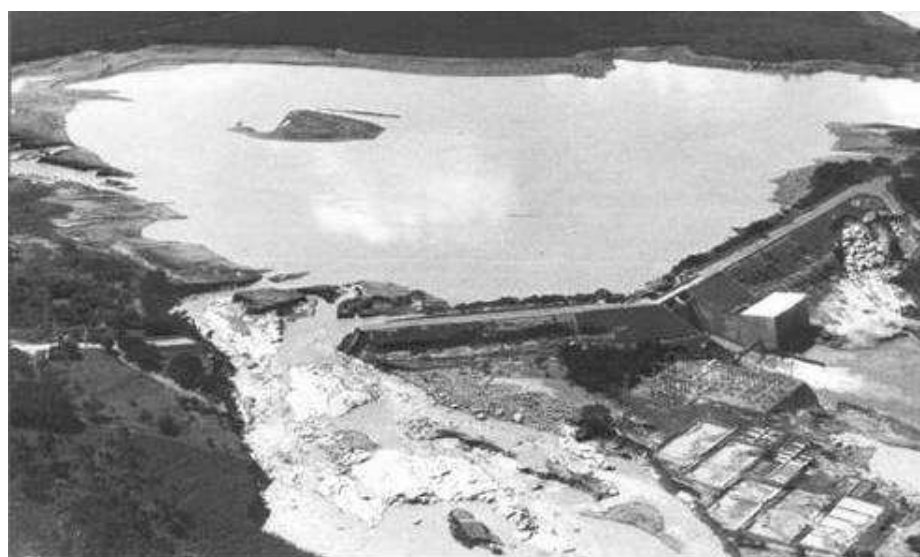
Figura 1.4: Maciço da UHE Armando Sales de Oliveira após o galgamento, em 21/01/1977. Fonte: CARVALHO (2007).
