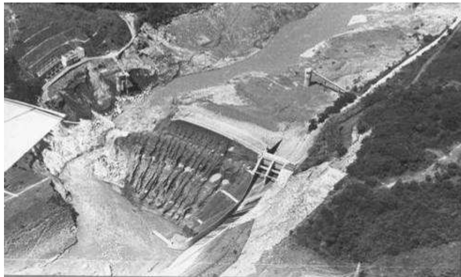
Figura 1.3: Maciço da UHE Euclides da Cunha após o galgamento, em 21/01/1977. Fonte: CBGB (1982b).
