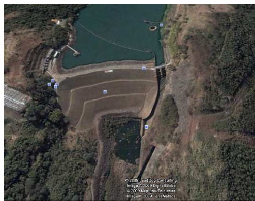
(b) Vista geral da barragem. Fonte: Google (2008).
