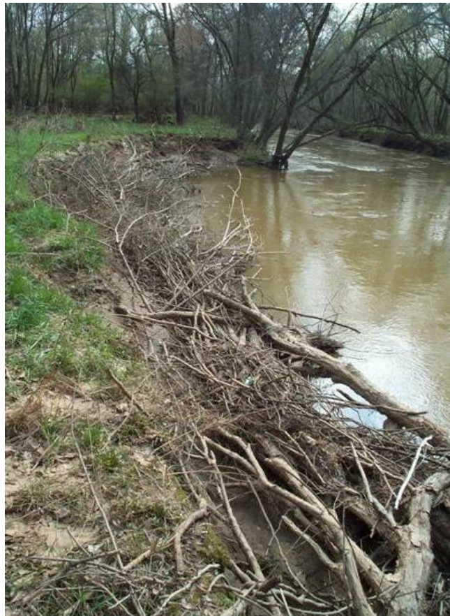
Figura 3.10: Margem protegida com galhos de árvores
