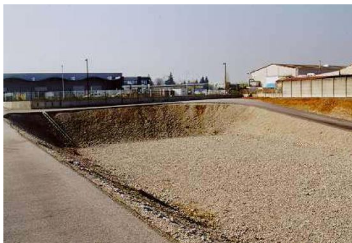
Figura I.12: Bacia de infiltração (medidas em cm) Foto: Márcio Baptista
