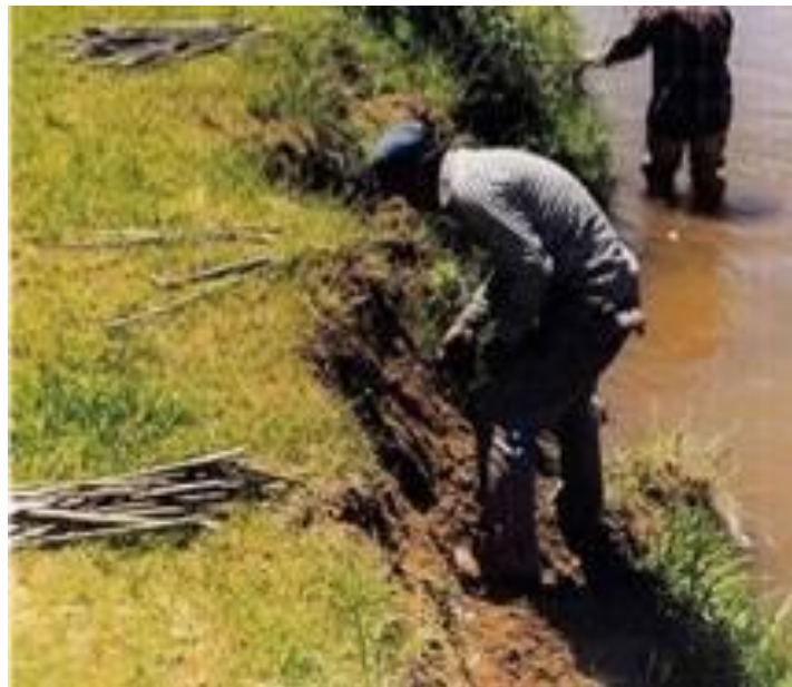
Figura 3.5: Cravação de estacas “vivas” Fonte: www.foggymtn.com/LiveStakes.html
