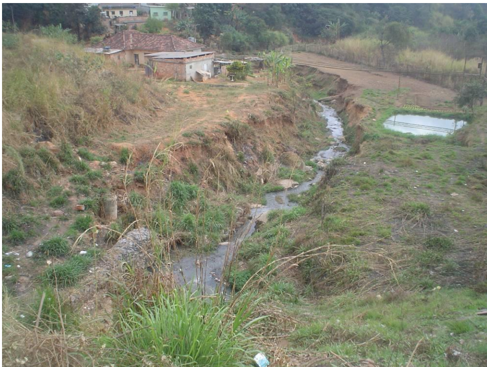
Figura 5.7: Trecho 18 à jusante após o bueiro da rua Ópera
