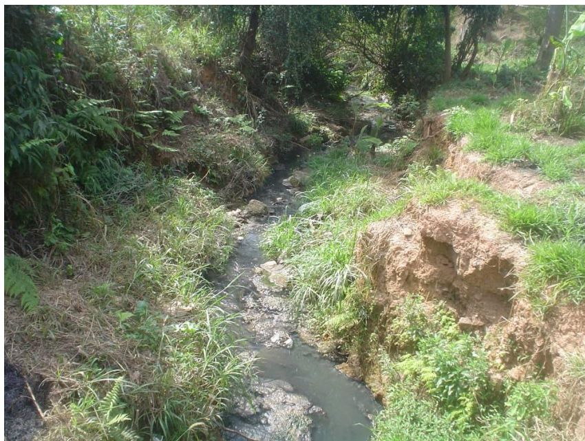
Figura 5.9: Trecho 18A, a jusante do lançamento do trecho canalizado da Vila CEMIG
