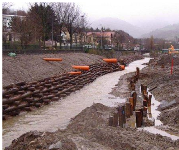
Figura 3.17: Contenção de margem em “cribwall” Fonte: http://naturlink.sapo.pt
