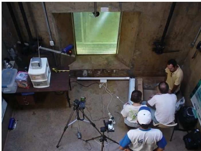
Figura 1.2: Sala de observação do mecanismo de transposição instalado em Igarapava. Esta Sala de Observação foi construída abaixo do nível da água para possibilitar a observação dos peixes que utilizam o mecanismo de transposição.
