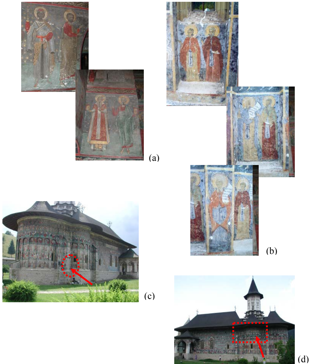
Figura 3.26 – Igreja da Ressurreição (Mosteiro de Sucevița) – afrescos internos avaliados pela SLDV (a), afrescos externos avaliados pela SLDV (b), área da parede norte avaliada pela termografia (c), área da parede sul avaliada pela termografia (d)
