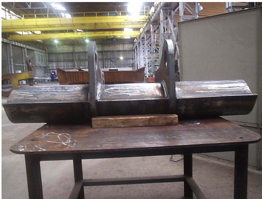
FIGURA 5.9: Vista da viga já soldada.
