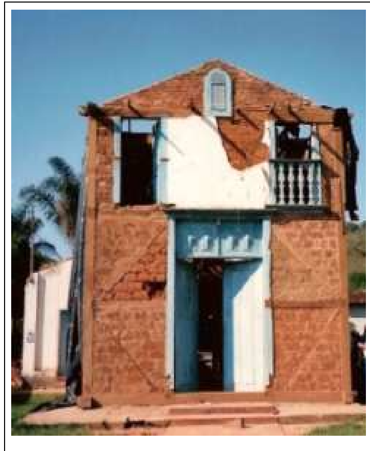
FIGURA 3.3 – Foto da capela. Alvenaria de vedação em adobe
