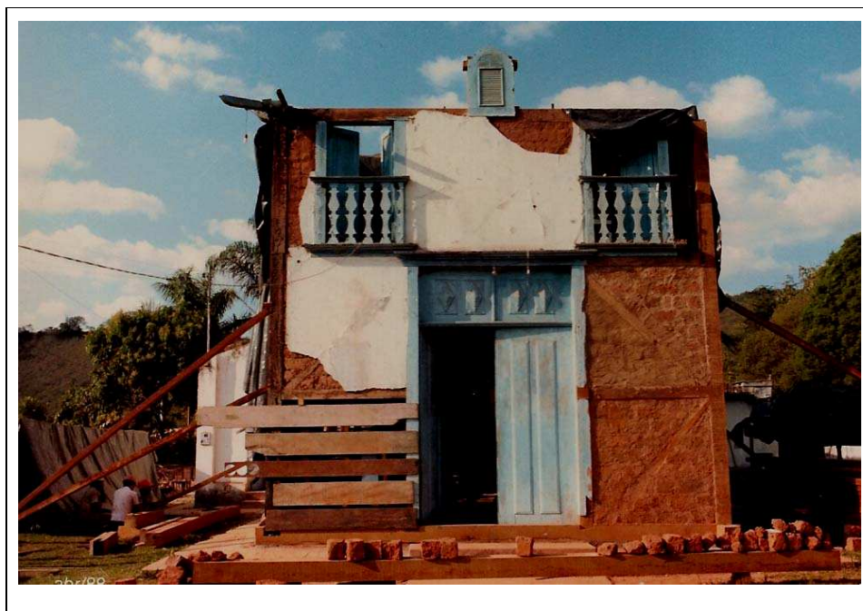
FIGURA 2.3 - Foto da intervenção na fachada de adobe e estrutura autônoma
