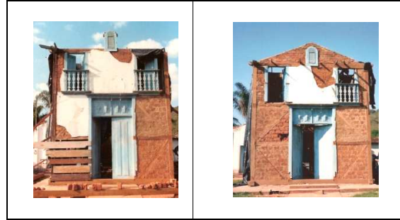
FIGURA 5.5 – Fotos da restauração da Capela
