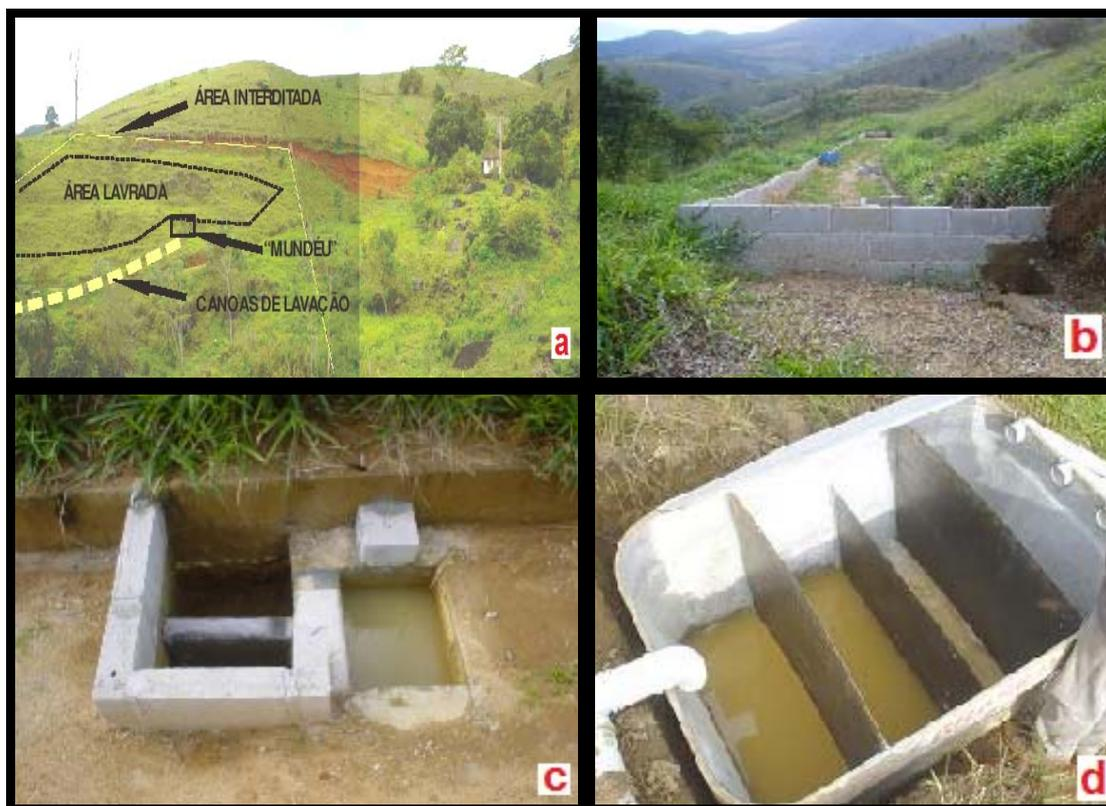
**Figura 4** – (a) Vista da área contaminada; (b) barreira de contenção; (c) caixas de sedimentação; (d) Tanques de sedimentação
