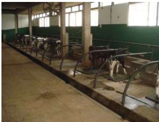
Figura 5. Instalações da Clínica de Ruminantes do Departamento de Clínica e Cirurgia da Escola de Veterinária da UFMG.
