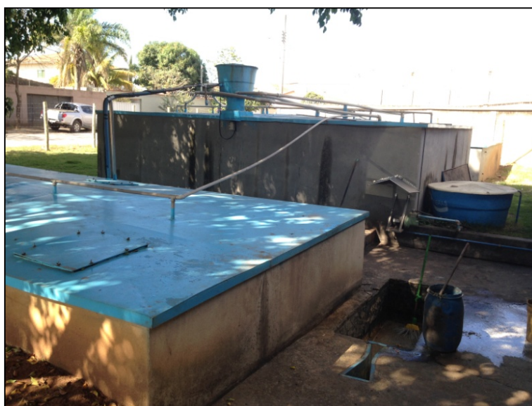
Figura 7. Vista geral da ETE.
