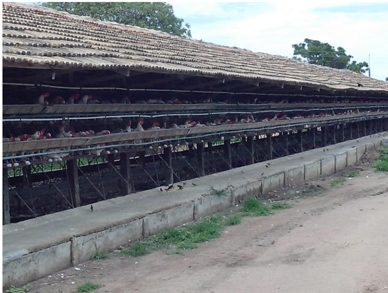
Anexo 3 – Fotografia da infraestrutura dos galpões das granjas avícolas.
