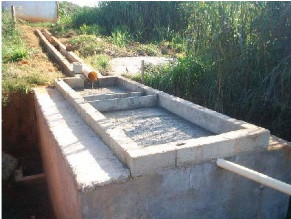
Figura 5. Vista do decantador
