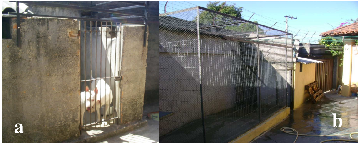
Figuras 6. Residência 5, antes (fig. 6a) e depois (fig.6b) da reforma do canil. Figura 6a: canil com presença de muro chapiscado. Figura 6b: muro rebocado, mas cama de madeira no interior do canil e telhado sem forro.
