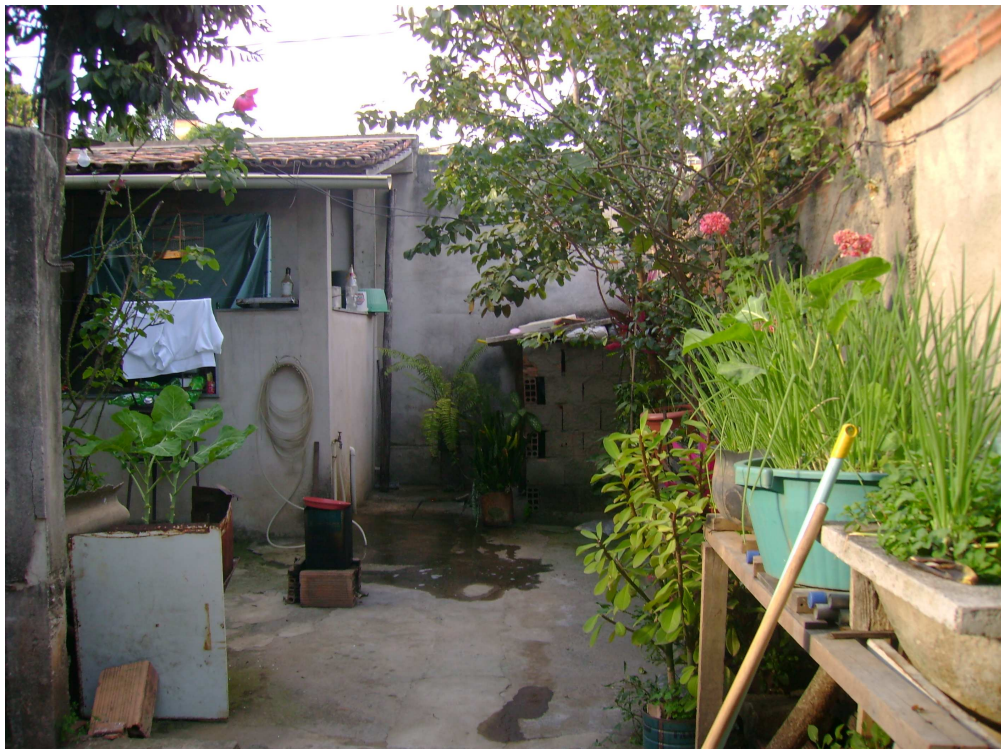
Figura 7: Residência 7. Parede do quintal e canil com áreas sem reboco e áreas de muro chapiscado.
