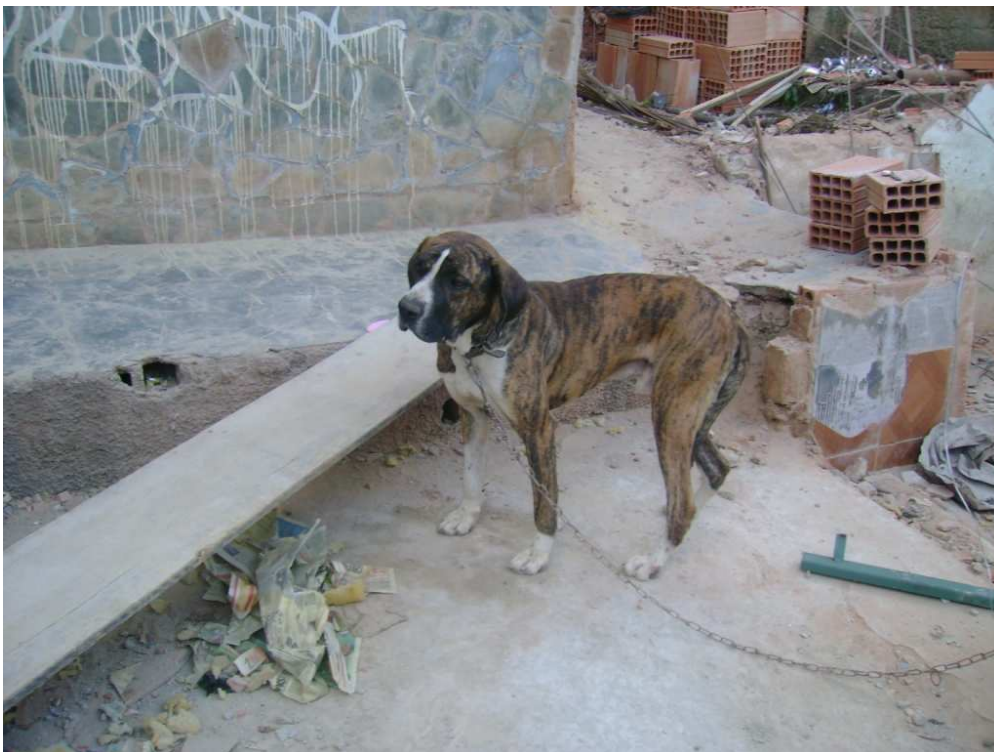
Figura 4. Residência 3. Muro chapiscado e presença de entulhos de madeira e tijolos.
