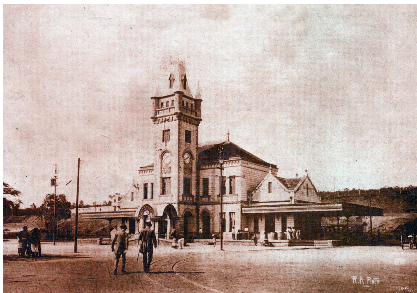
FIGURA 6: Estação de Bello Horizonte - Fotografia de Raymundo Alves Pinto para o Álbum de Bello Horizonte , realizado para a prefeitura da nova capital. Fonte: Arruda (2003).
